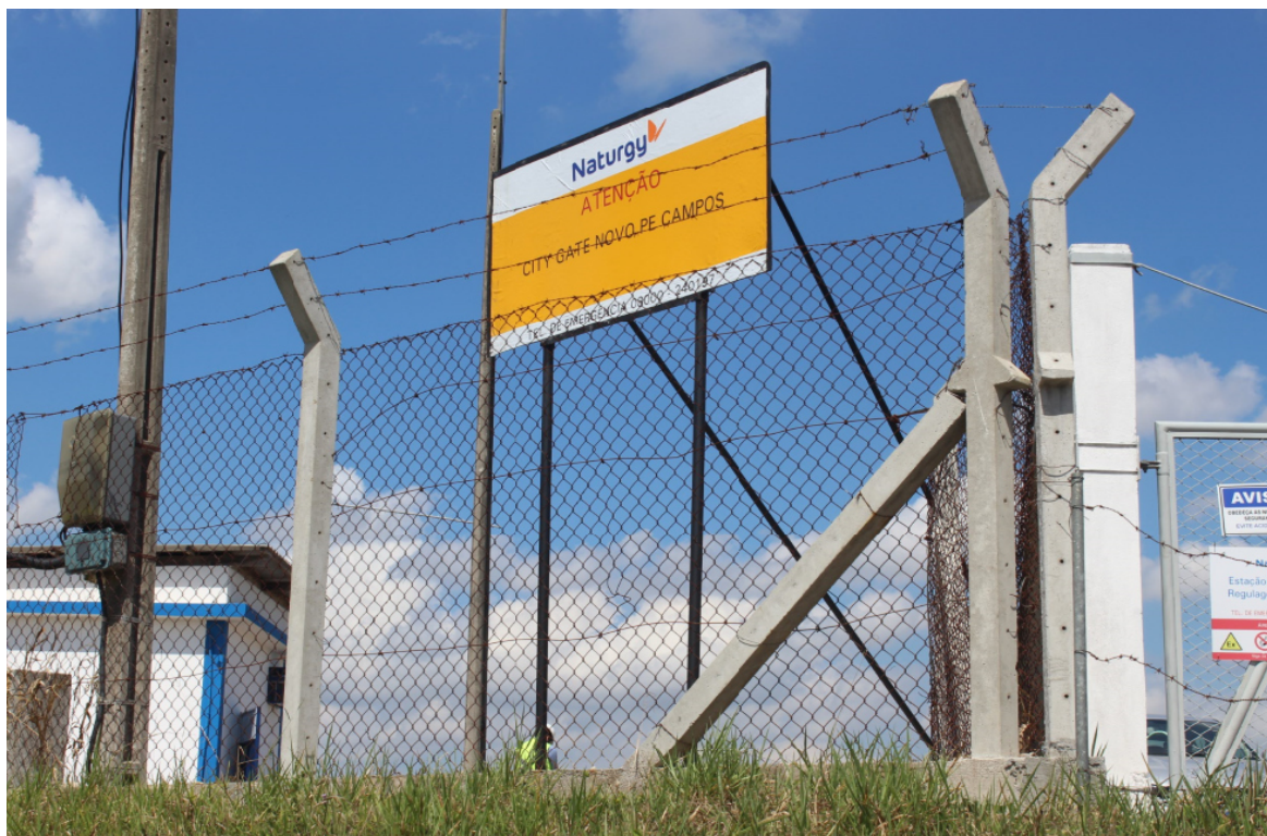
Foto 1: Placa de identificação da Estação
