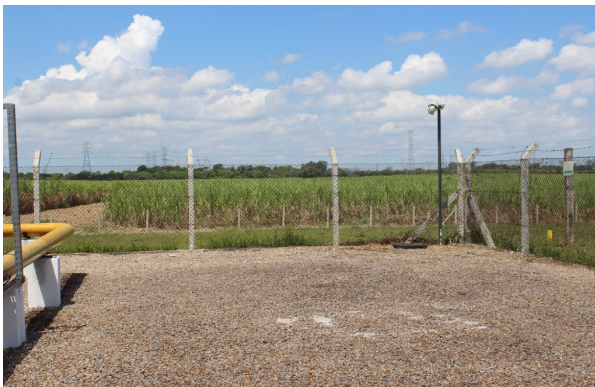
Foto 14: Local para complementar sinalização de rota de fuga
