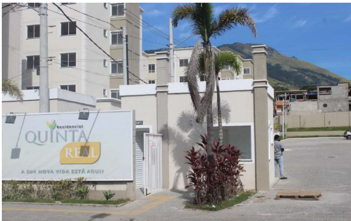
Foto 1 : fachada do condomínio
