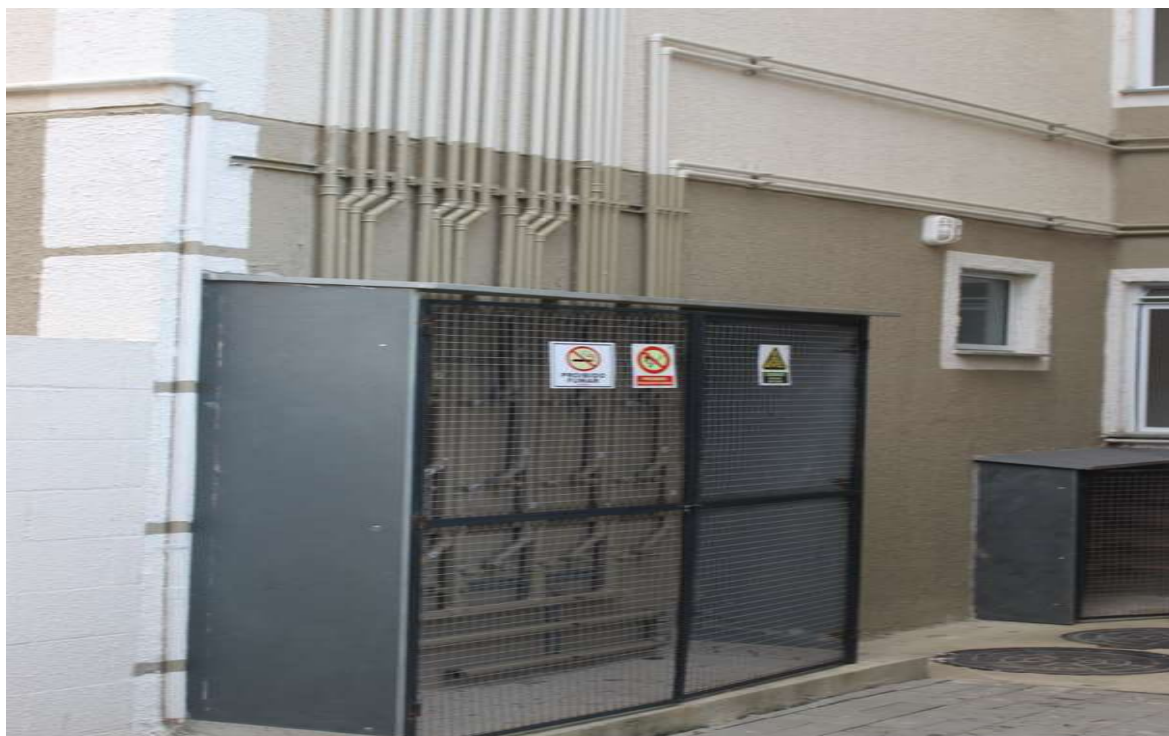
Foto 4 : instalação do PI
