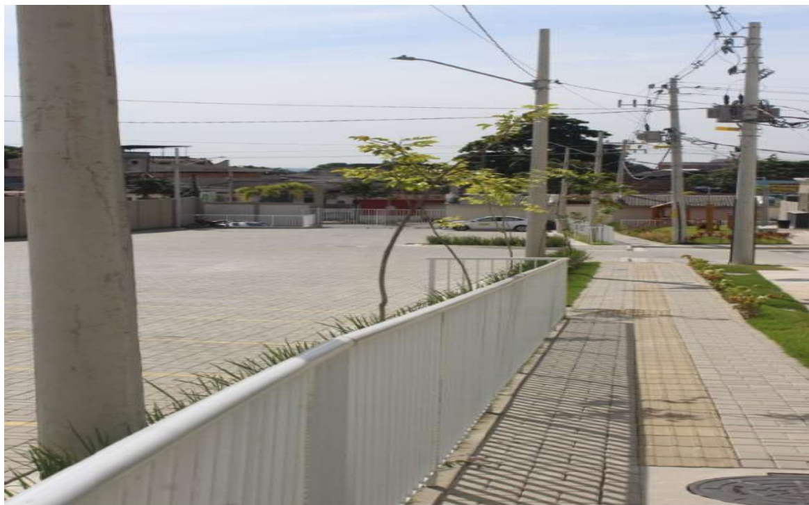
Foto 2 : situação atual das obras do condomínio
