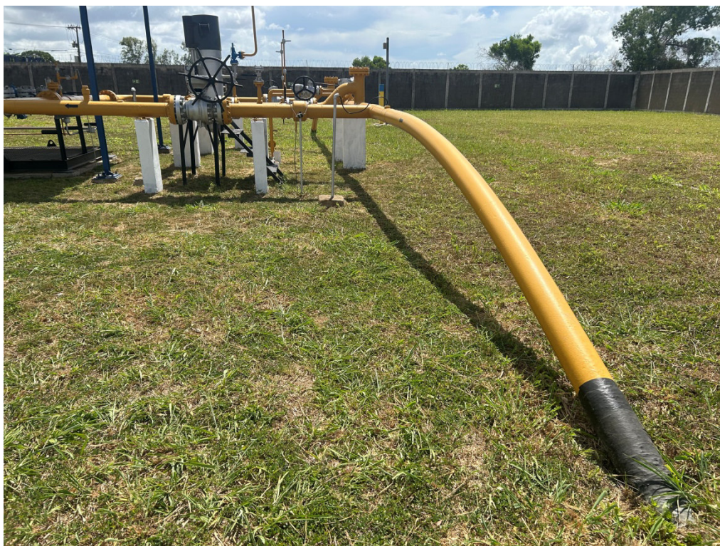
Foto 3: Canhão receptor de PIG.
