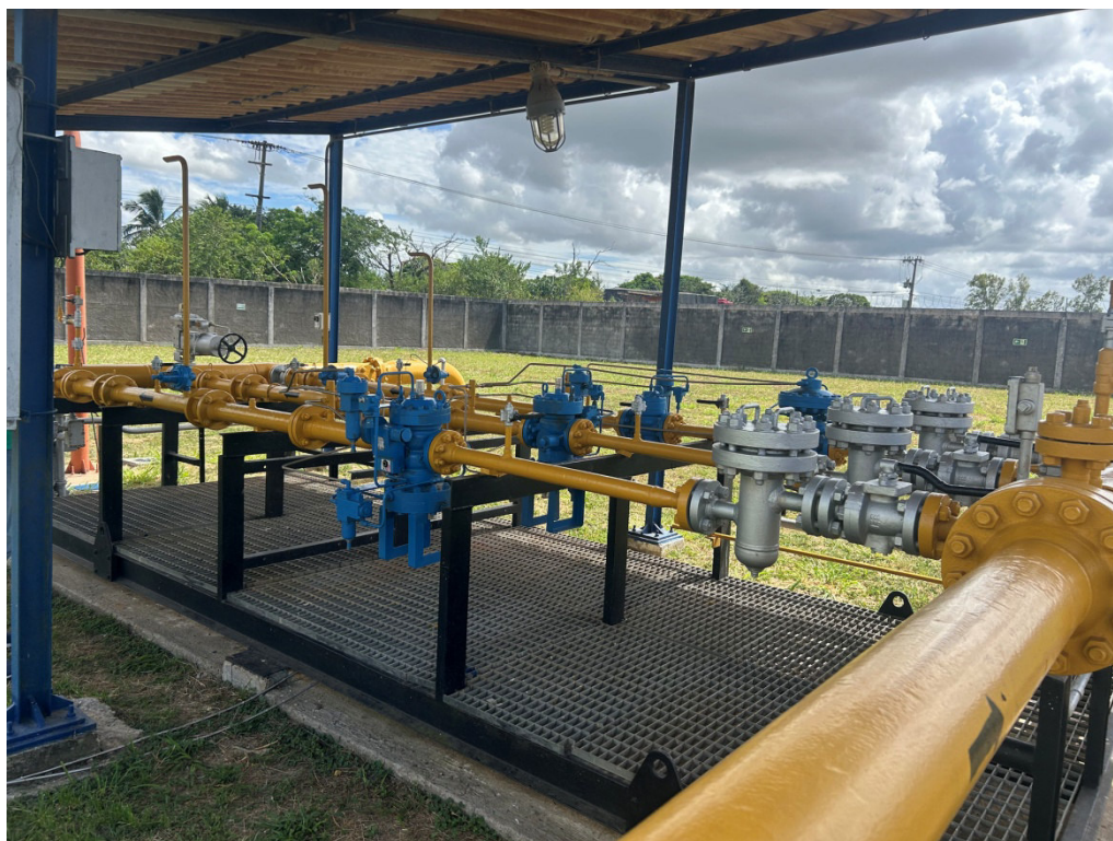
Foto 5: Estação aérea de Tapera com seus 3 reguladores de pressão.
