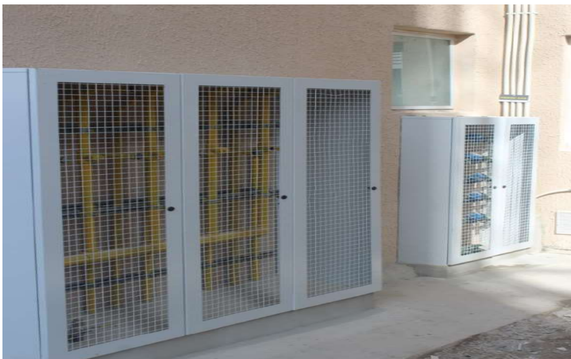
Foto 3 : instalação do PI
