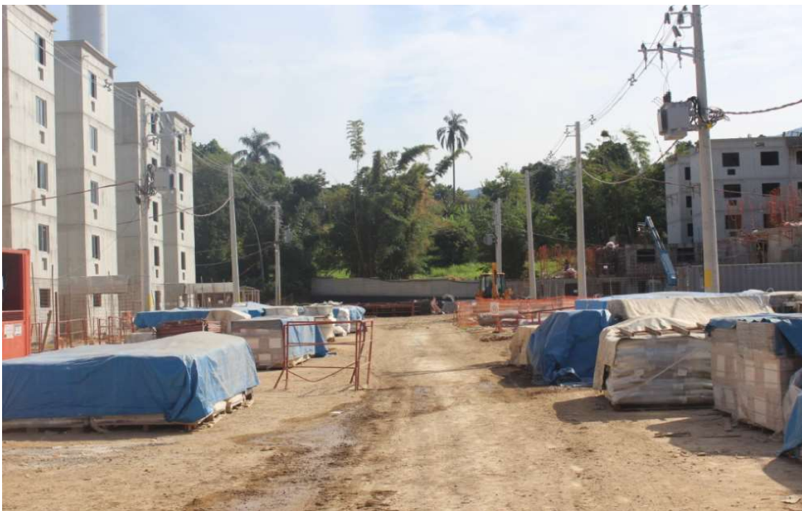
Foto 2 : situação atual das obras do condomínio
