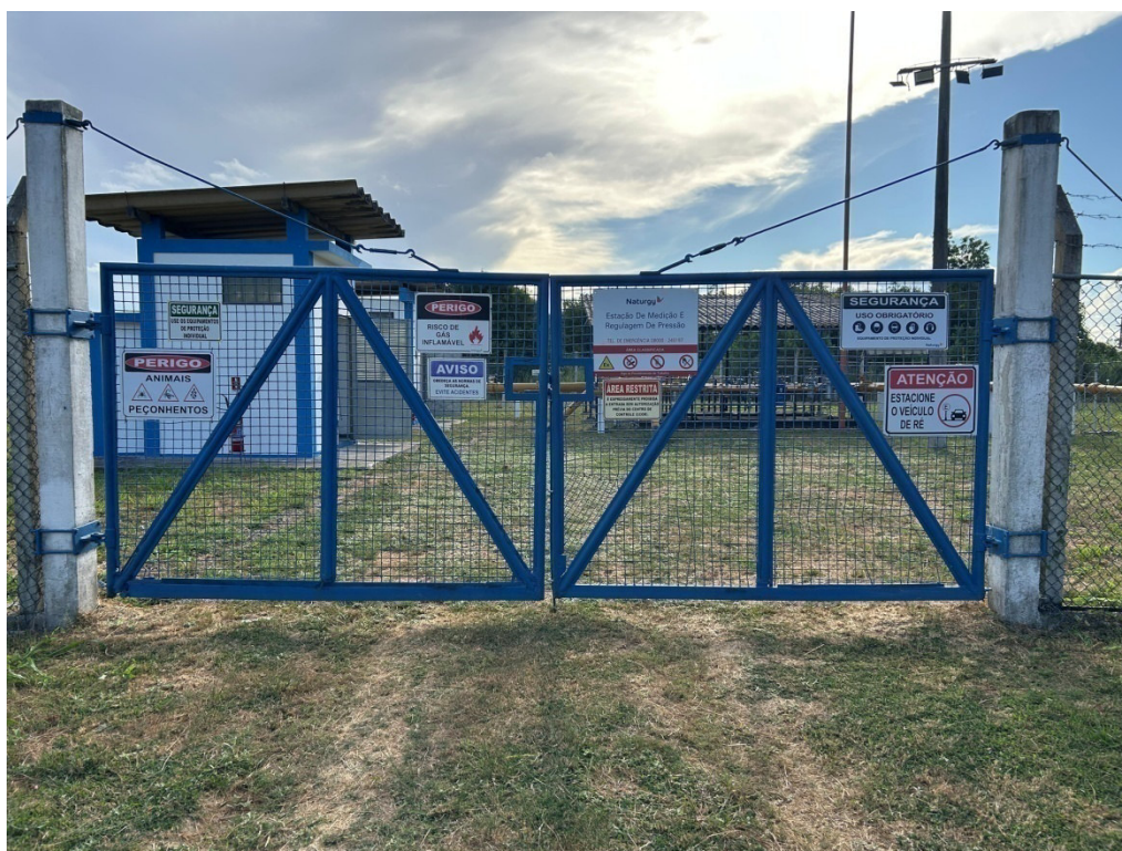
Foto 2: Portão de entrada da estação com as placas de sinalização.
