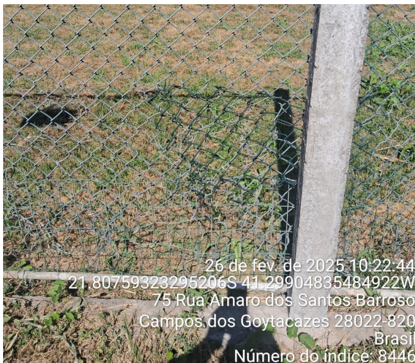
Foto 9: Falha na cerca reparada.
