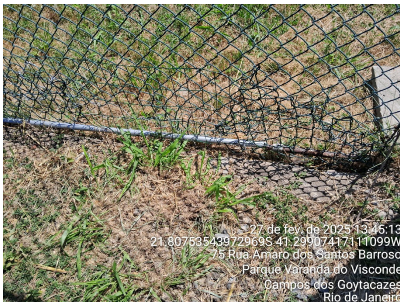
Foto 11: Falha na cerca reparada.
