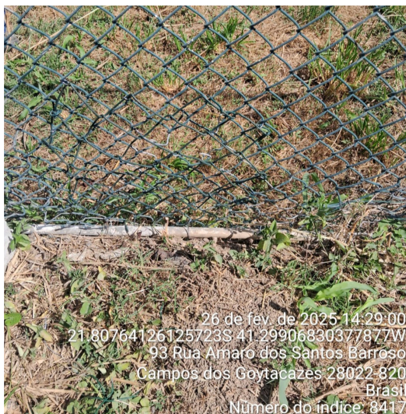
Foto 10: Falha na cerca reparada.
