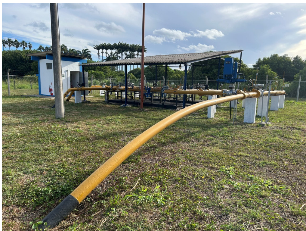
Foto 4: Canhão receptor de PIG da estação de Donana.
