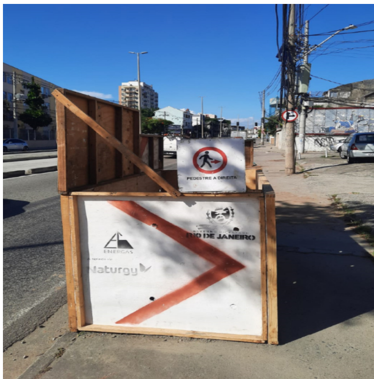
Foto 3: Isolamento e sinalização de trecho
