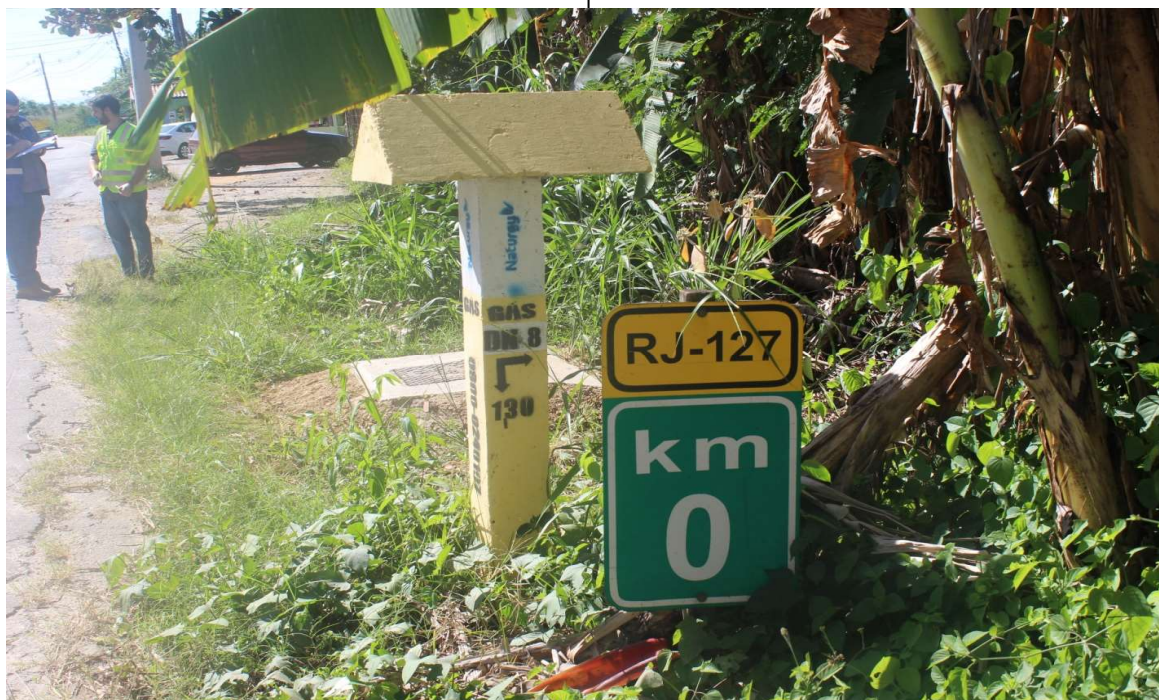
Foto 1: Caixa de válvula de interligamento de redes e marco horizontal indicando a presença de rede de Gás Natural.
