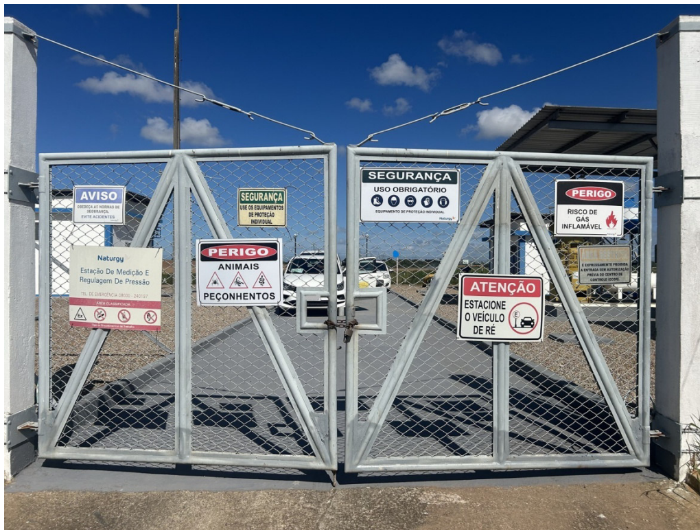
Foto 1: Entrada da ETC com sinalizações de segurança.
