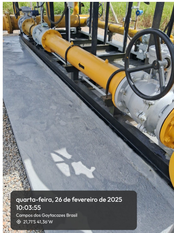
Foto 15: Desgastes na base de concreto da estação reparados.
