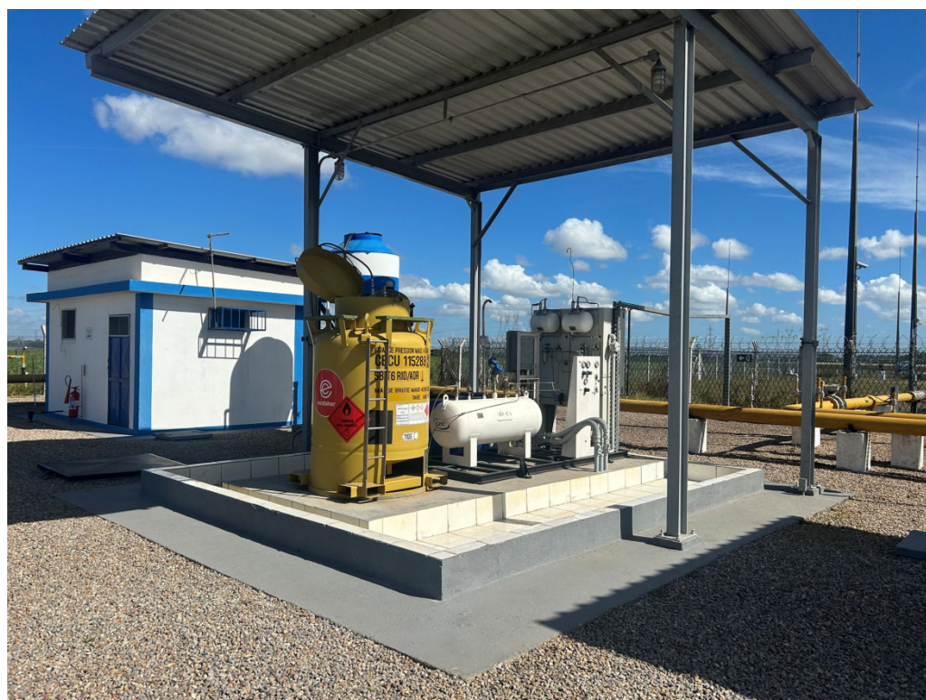
Foto 4: Câmara de cromatografia e estação de odorização.
