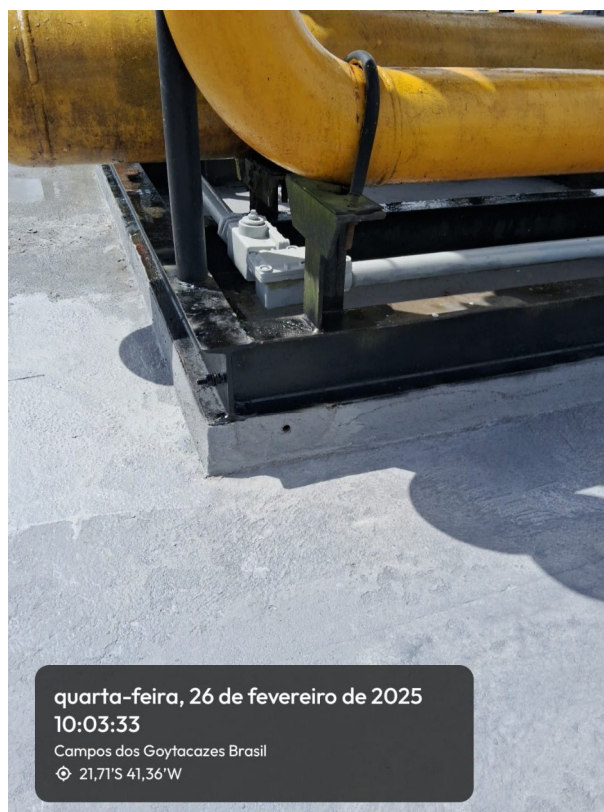
Foto 12: Desgaste na base de concreto da estação reparado.
