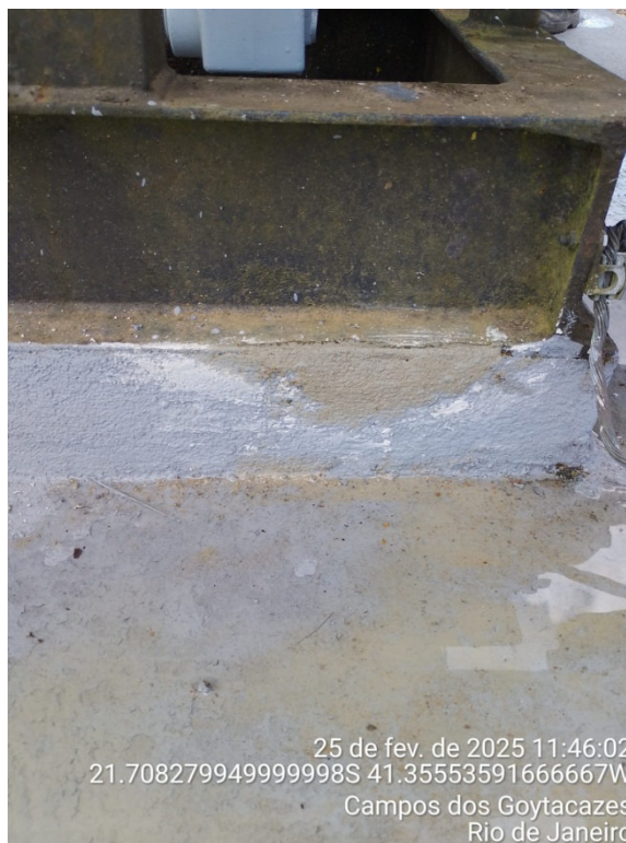
Foto 13: Desgaste na base de concreto da estação reparado.
