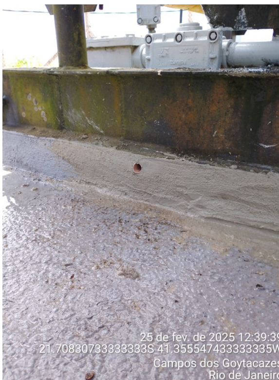
Foto 14: Desgaste na base de concreto da estação reparado.
