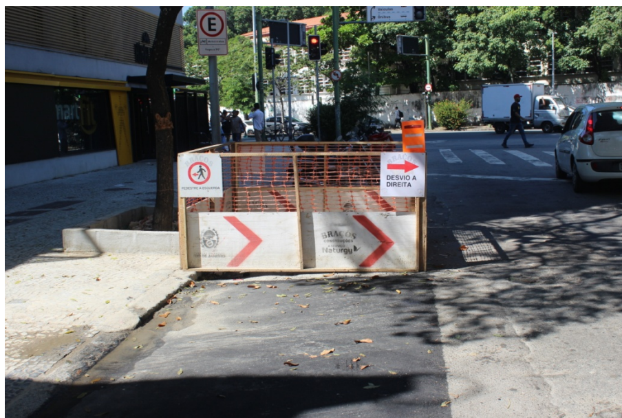
Foto 11: Recomposição na via e ponto de interligação da rede (lado ímpar).
