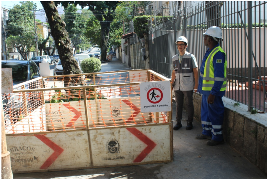
Foto 5: Isolamento de obra e sinalização de desvio de pedestre.
