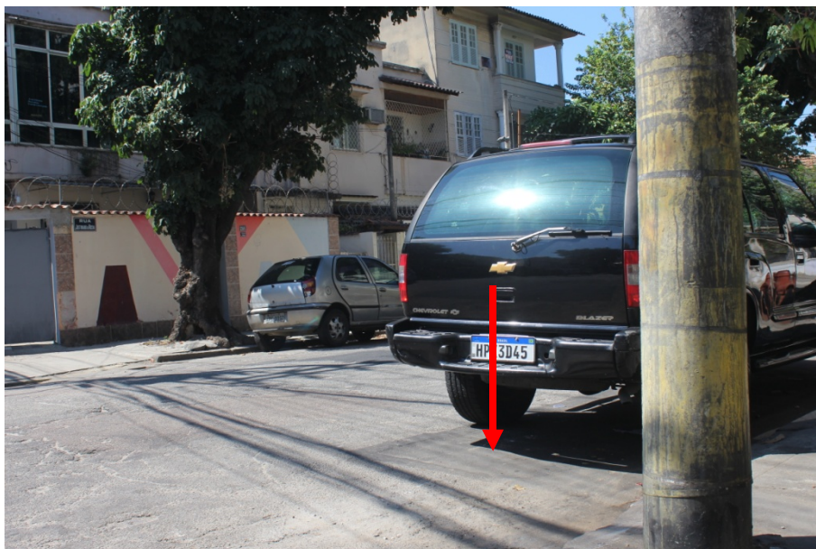
Foto 15: Ponto de interligação da rede (entre a rua Marechal Zenóbio da Costa e Rua Justiniano da Rocha)
