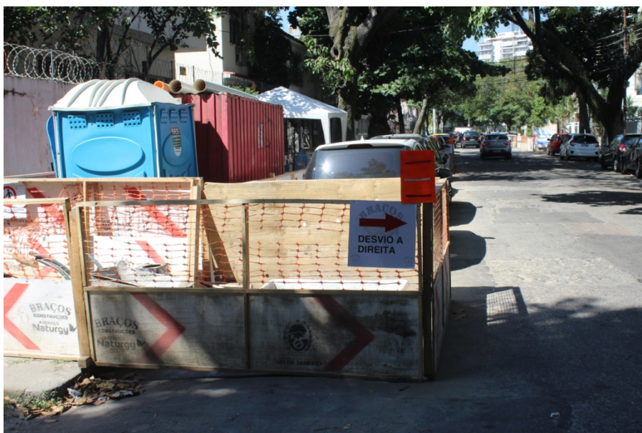
Foto 16: Placa de sinalização noturna instalada.
