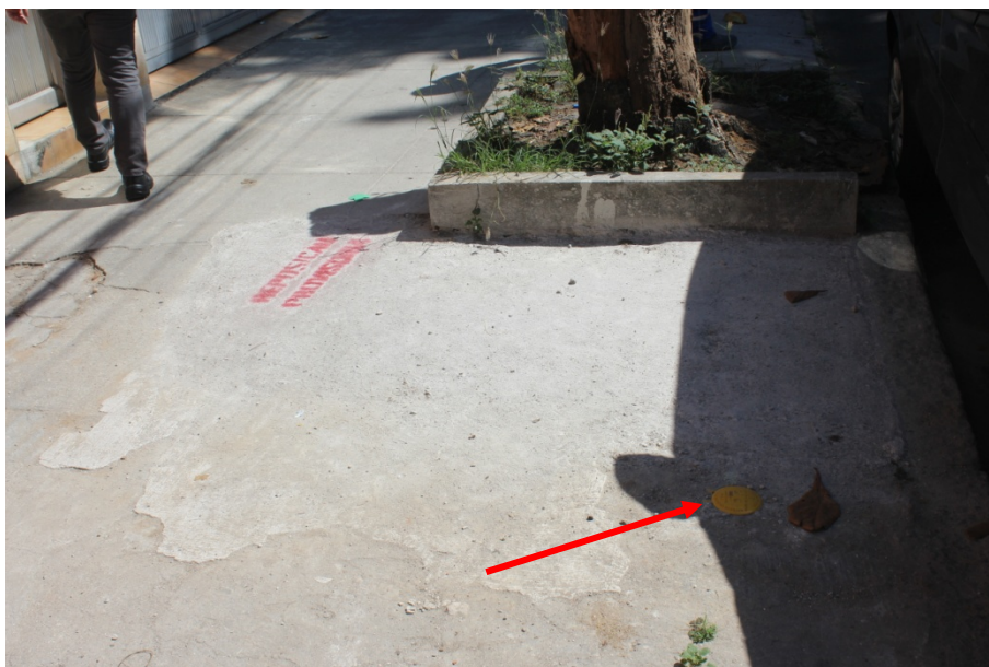
Foto 13: Recomposição provisória no passeio e marco plano (lado par).
