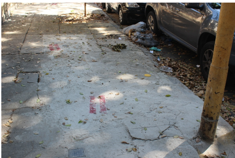
Foto 14: Recomposição provisória no passeio (lado par).
