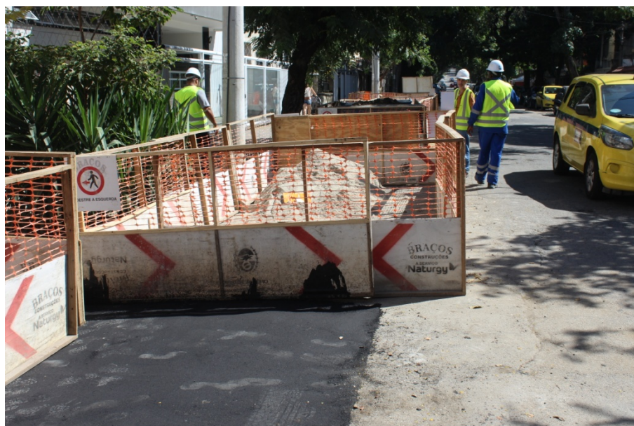
Foto 12: Recomposição na via e isolamento de obra (lado par).
