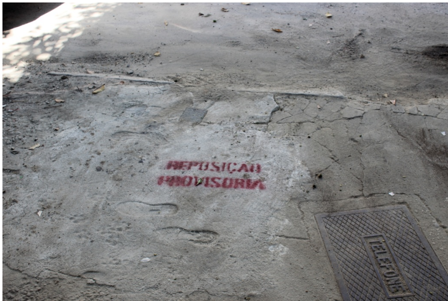
Foto 4: Recomposição provisória (lado ímpar).
