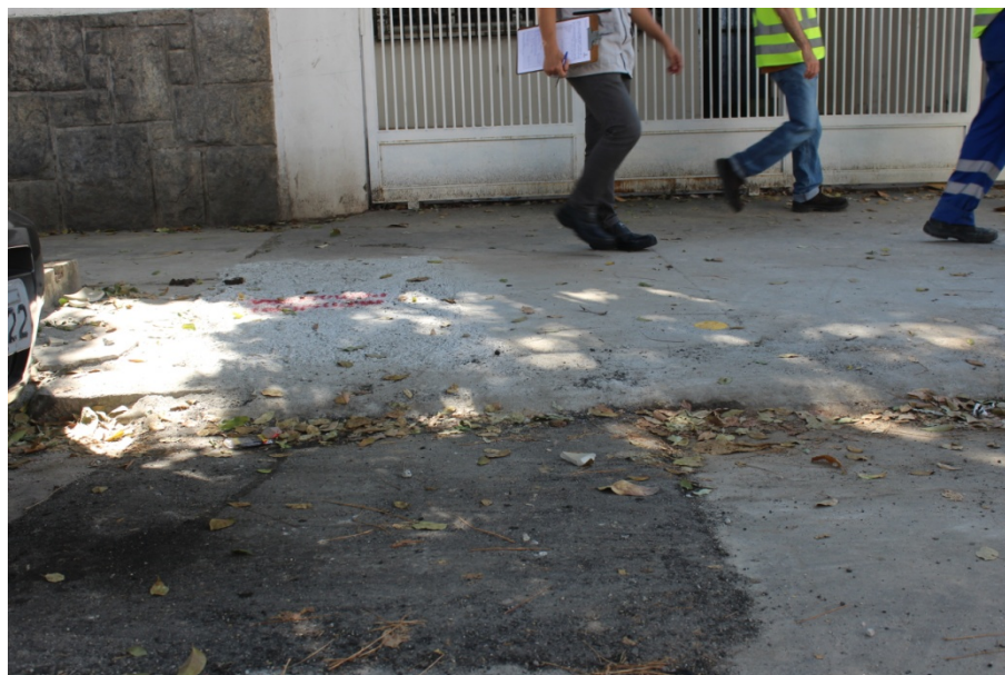
Foto 2: Recomposição provisória na via e no passeio (lado ímpar)
