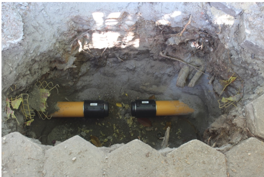
Foto 6: Rede PE Ø110 mm seccionada para identificar origem de escapamento (lado par)
