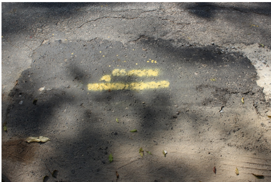
Foto 10: Recomposição provisória na via (lado ímpar).
