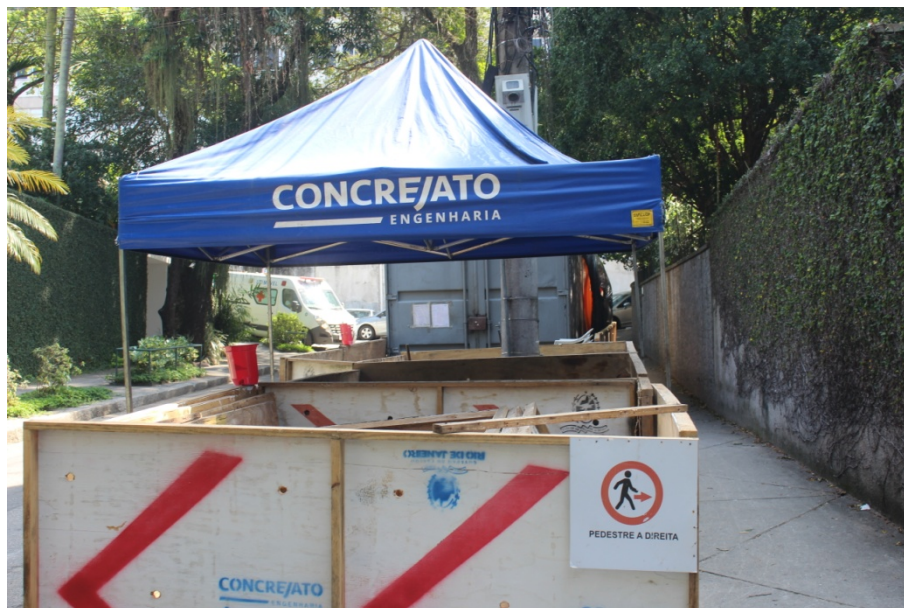
Foto 5: Local de vivência e armazenamento de material.
