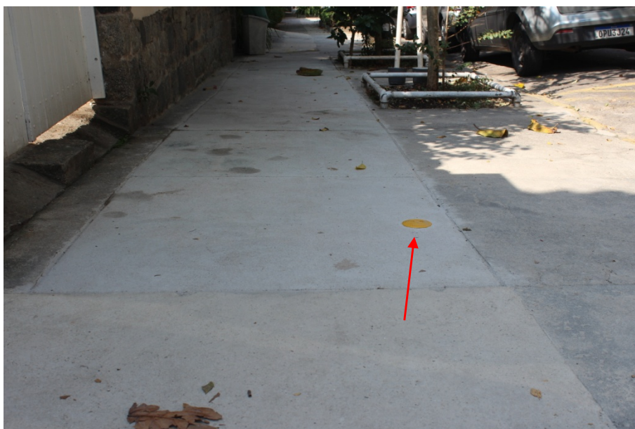
Foto 4: Recomposição permanente e marco plano (lado par).
