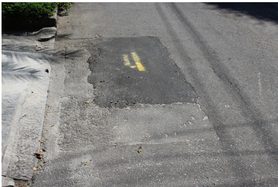
Foto 11: Recomposição provisória na via (lado ímpar).
