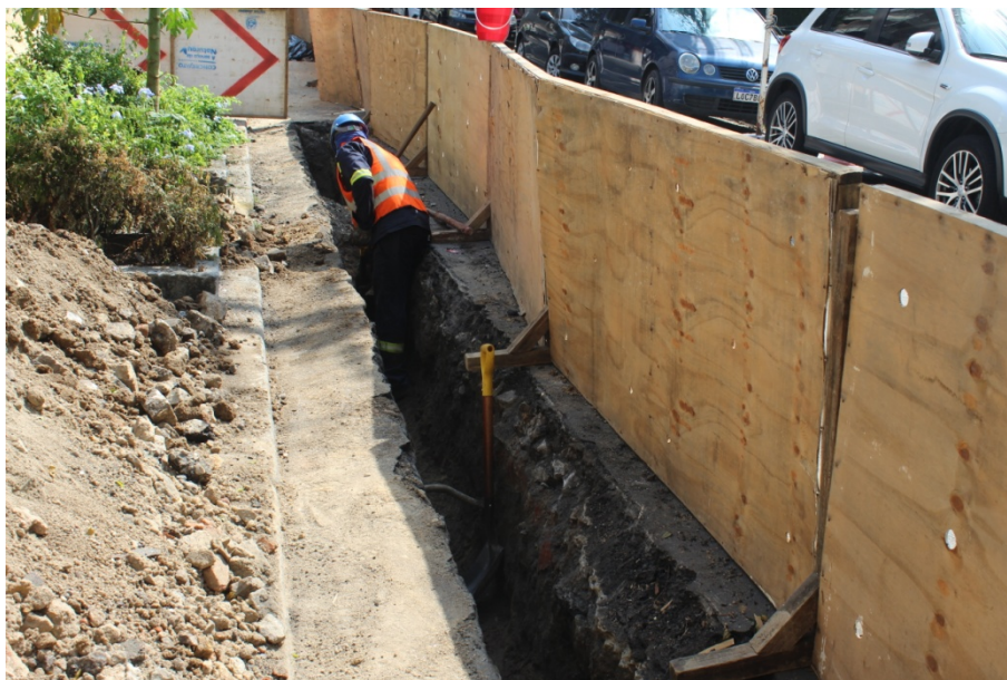
Foto 8: Realização de abertura de vala para assentamento de tubulação de gás (lado ímpar).
