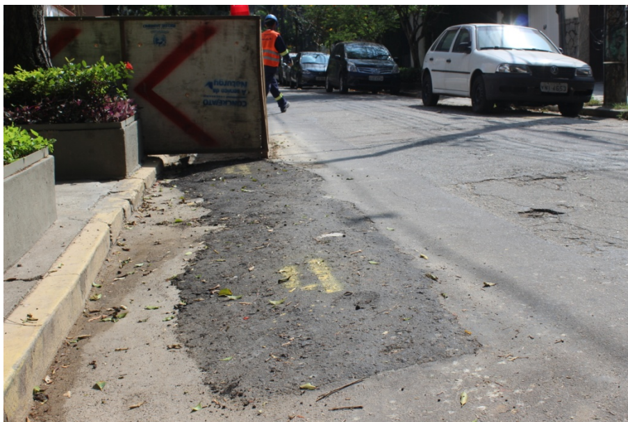
Foto 3: Recomposição provisória na via (lado par)
