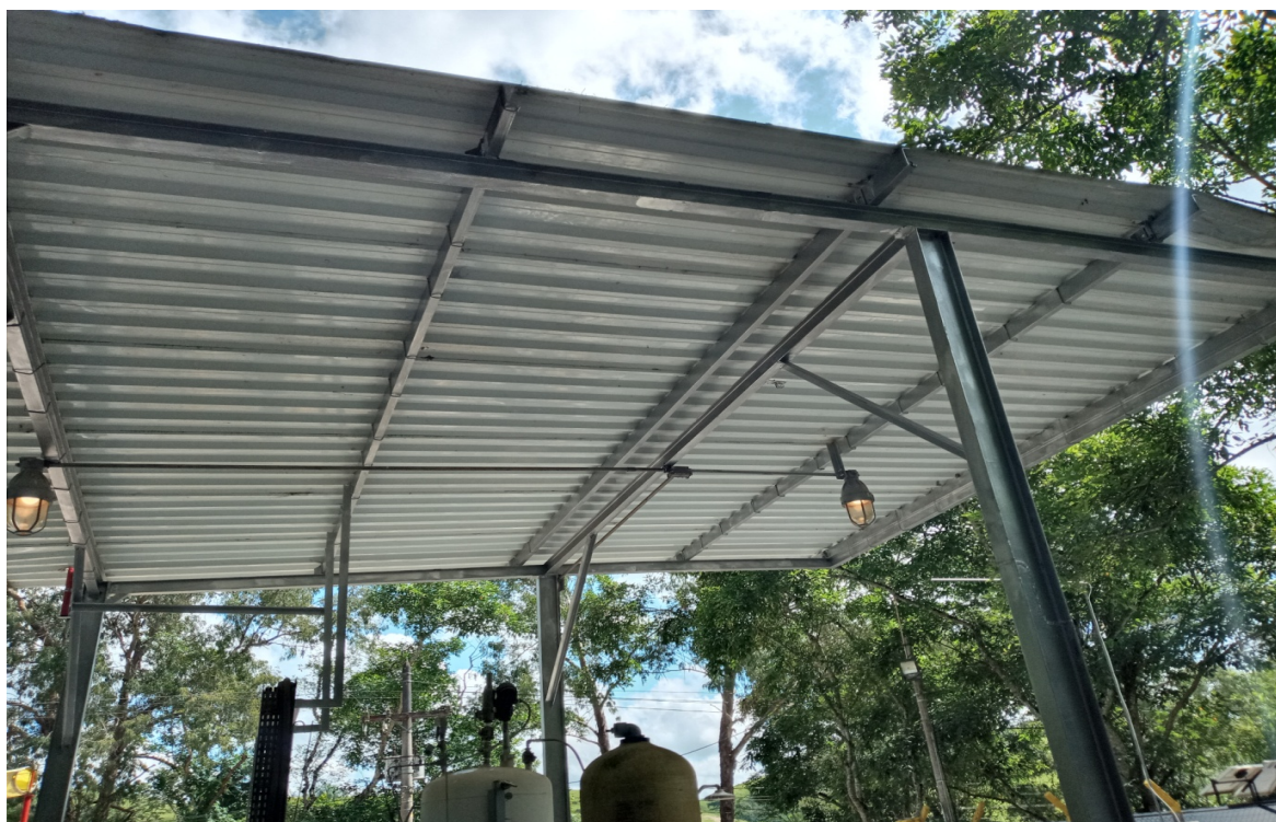
Foto 8: Cobertura da Estação
