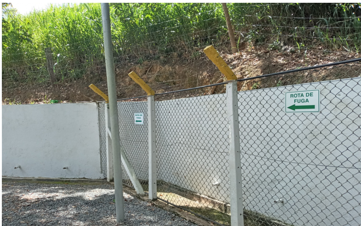
Foto 9: Sinalização de rota de fuga
