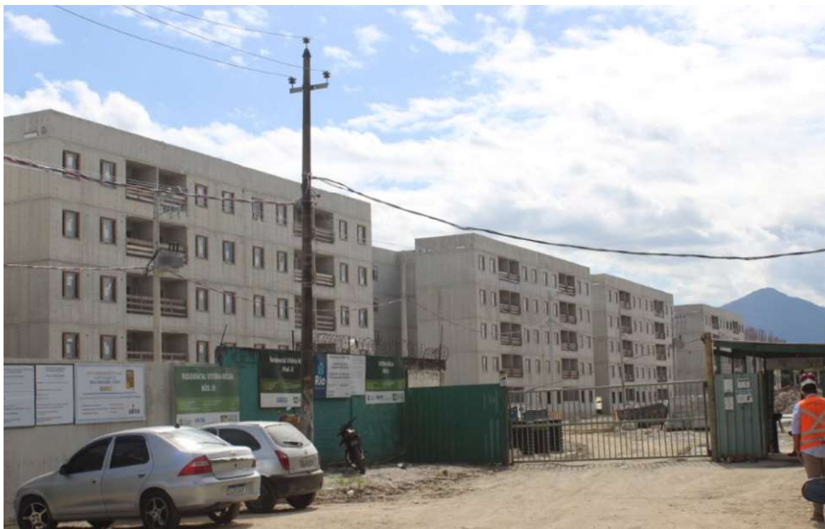
Foto 2 : situação atual das obras do condomínio
