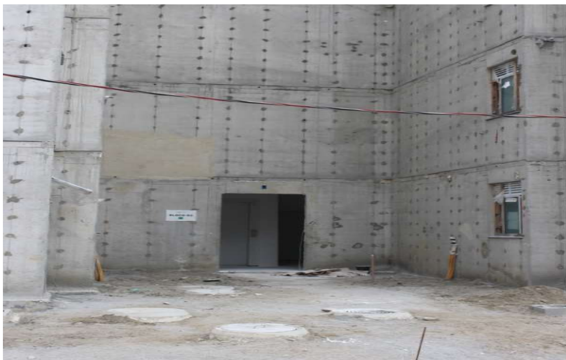
Foto 4 : local para instalação dos ramais
