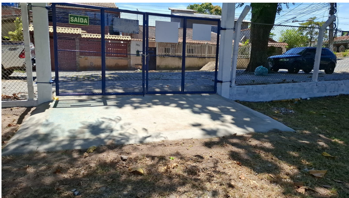
Foto 11: Piso de acesso consertado e nivelado.
