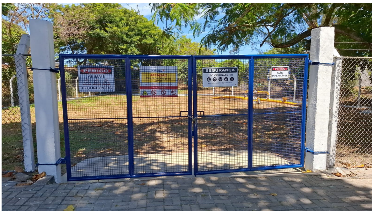
Foto 12: Portão de acesso nivelado.
