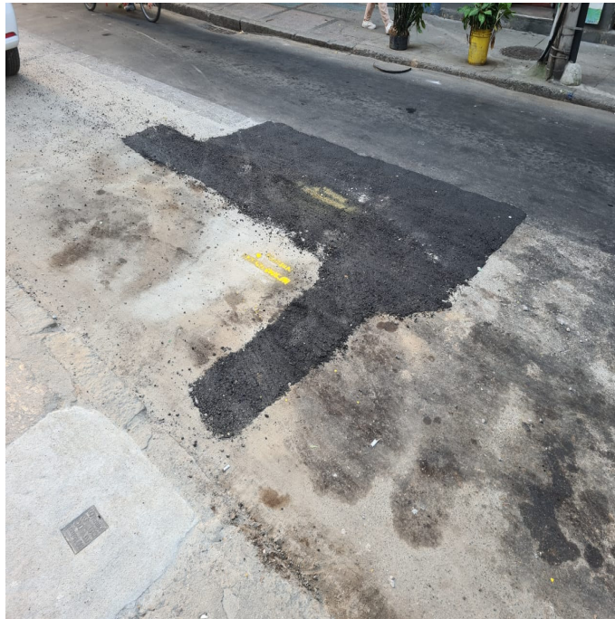
Foto 19: Adequação de recomposição da via (ainda provisório)
