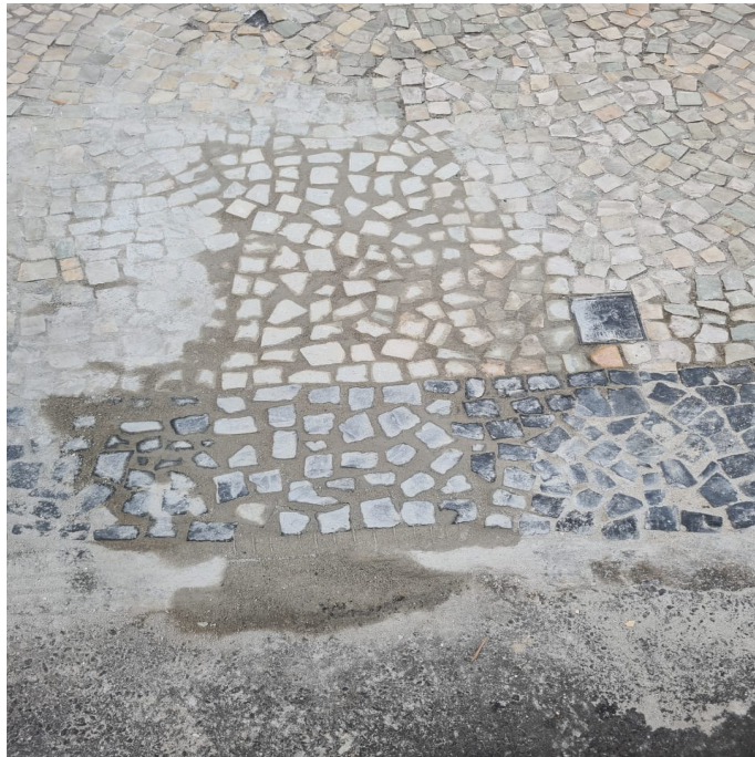
Foto 17: Adequação de recomposição com o assentamento de pedras portuguesas
