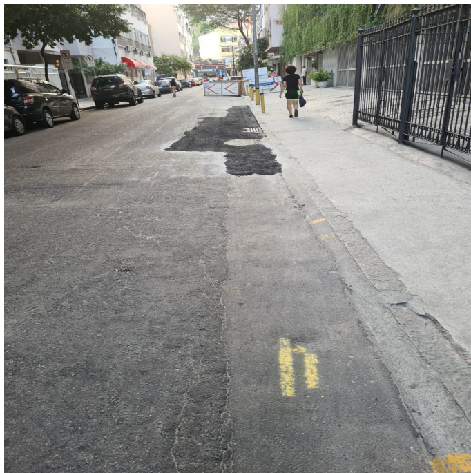
Foto 18: Adequação de recomposição da via (ainda provisória)
