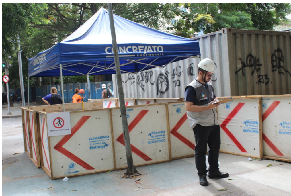
Foto 1: Área de convivência, com sinalização de desvio para pedestres e armazenamento de materiais contíguo.
