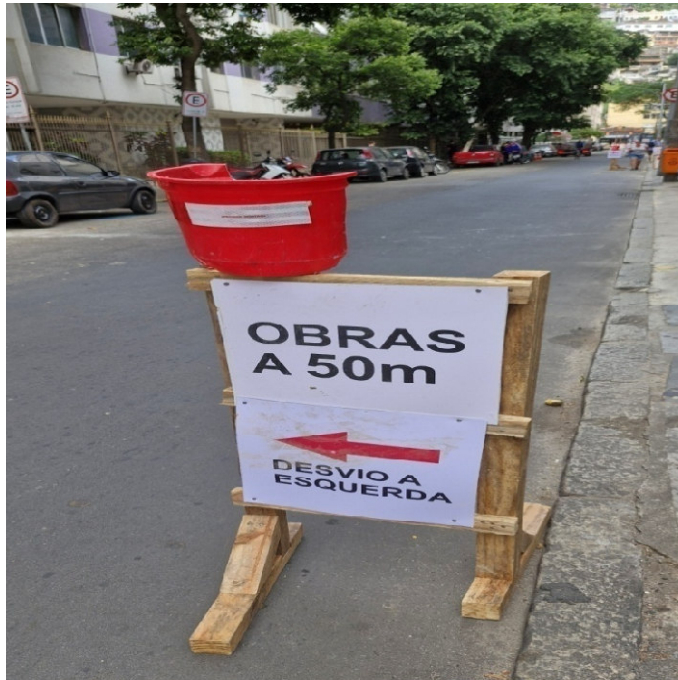
Foto 7: Sinalização de desvio para o trânsito, com sinalização noturna acoplada.
