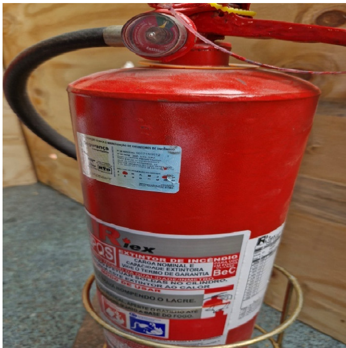
Foto 3: Extintor na área de vivência, recém inspecionado.
