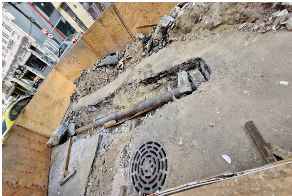
Foto 10: Duto de aço em estágio de finalização da inserção do polietileno interno. Detalhe para o entulho e resíduos acumulados por despejo irregular.
