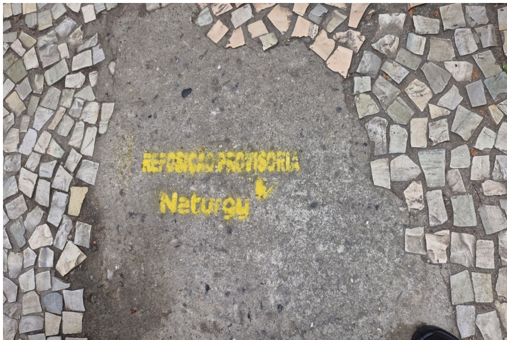
Foto 6: Sinalização de recomposição provisória.
