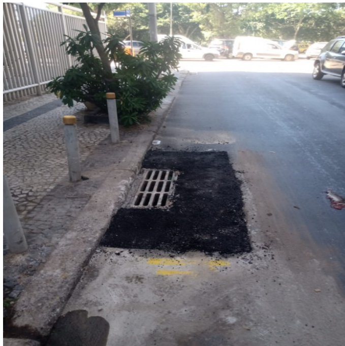
Foto 20: Adequação de recomposição em trecho onde ocorreu afundamento (ainda provisório)
