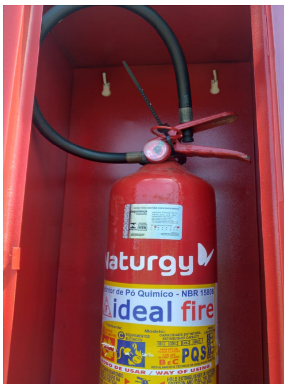
Foto 9: Troca do extintor e da caixa
