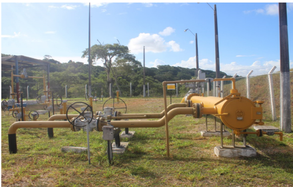
Foto 2: Lançador de PIG para UTE Mário Lago
