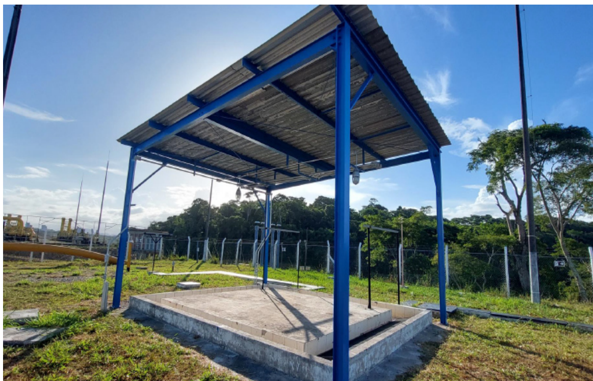
Foto 8: Estrutura e telhado (depois)
