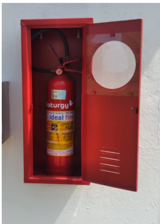
Foto 9: Troca do extintor e da caixa
