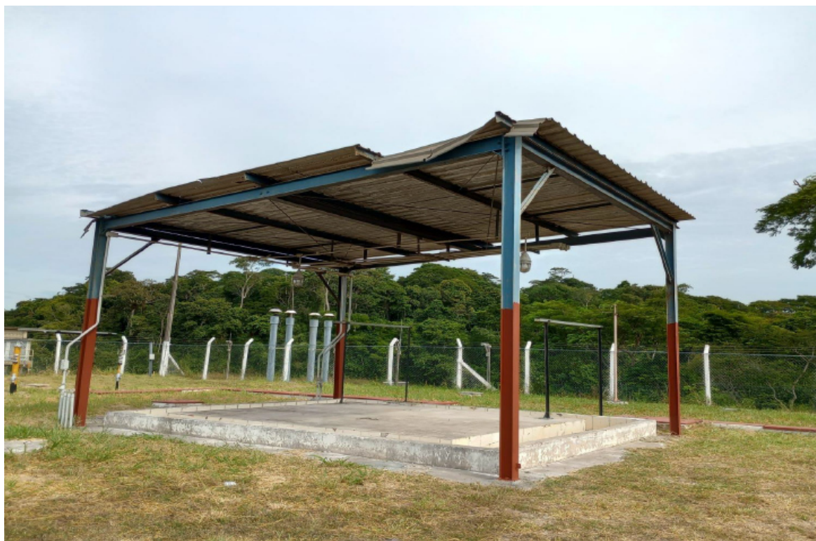
Foto 7: Estrutura e telhado (antes)
