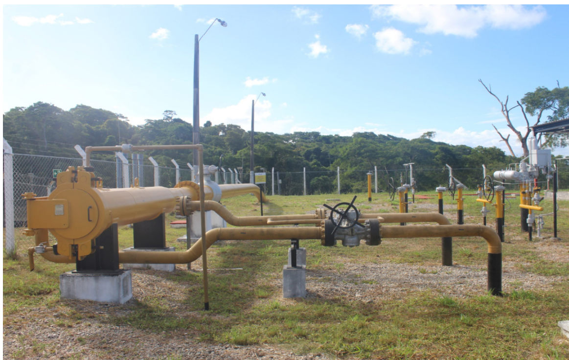
Foto 4: Lançador de pig para UTE Norte Fluminense
