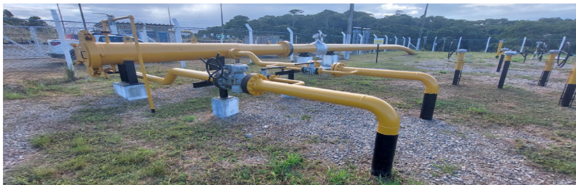
Foto 12: Pintura refeita das tubulações
