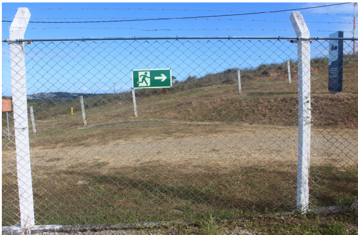
Foto 5: Placa de rota de fuga
