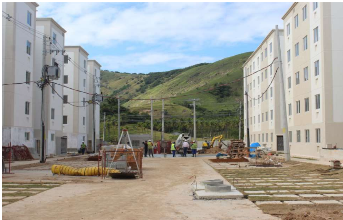
Foto 2 : situação atual das obras do condomínio
