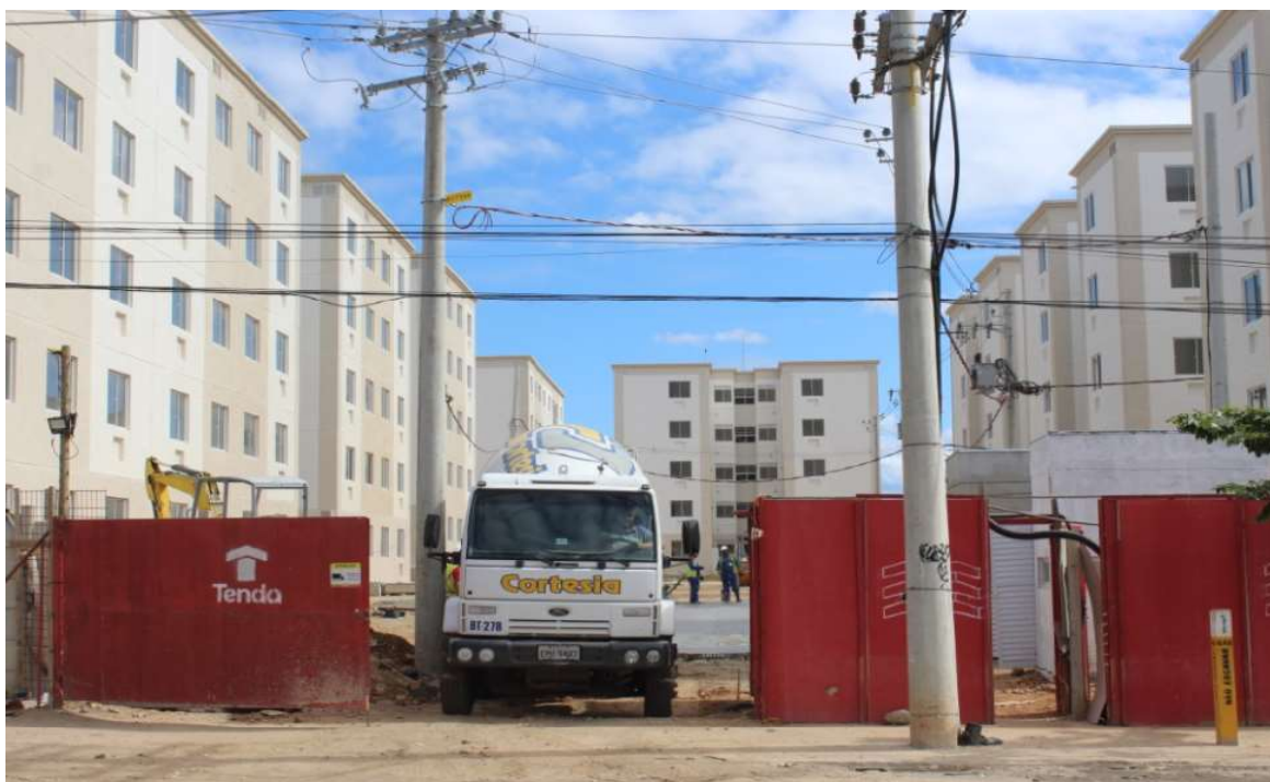
Foto 1 : fachada do condomínio
