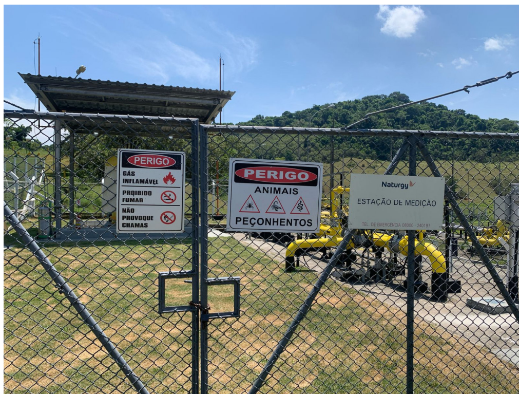
Foto 9: Placas de identificação, de segurança e de advertência da estação.
