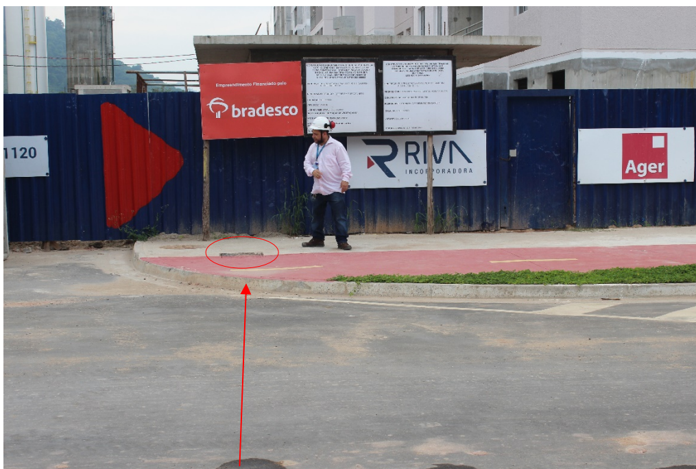
Foto 7: Ponto de finalização da obra (Caixa de válvula)
