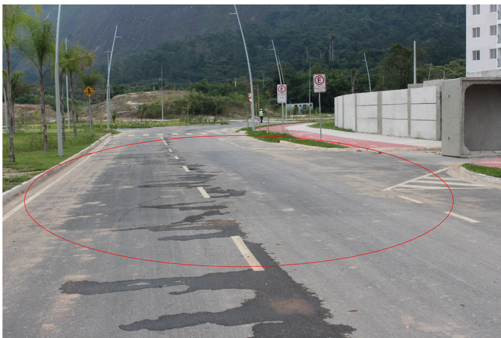
Foto 5: Recomposição asfáltica do trecho onde ocorreu a travessia de rede por método destrutivo
