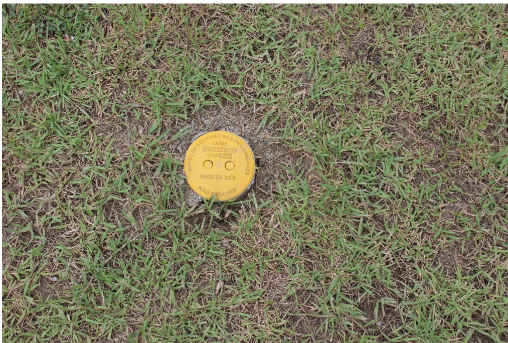
Foto 9: Marco plano identificando a presença de rede de gás enterrada
