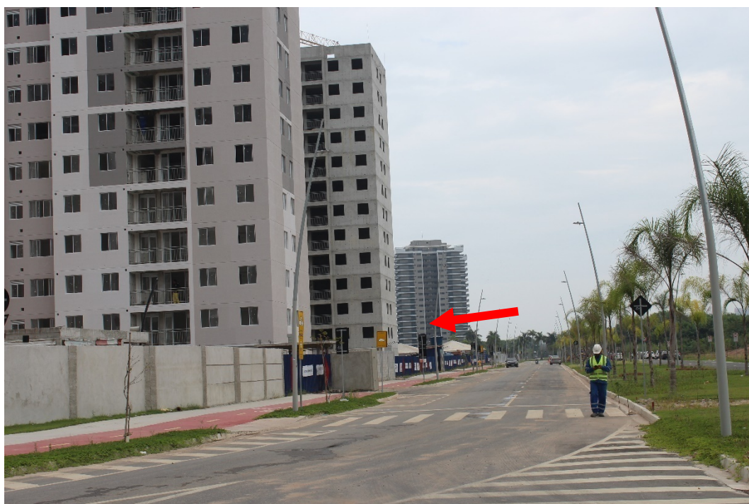
Foto 10: Empreendimento a ser atendido.
