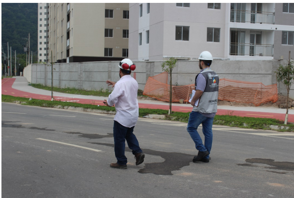
Foto 6: Inspeção do trecho da obra (AGENERSA).
