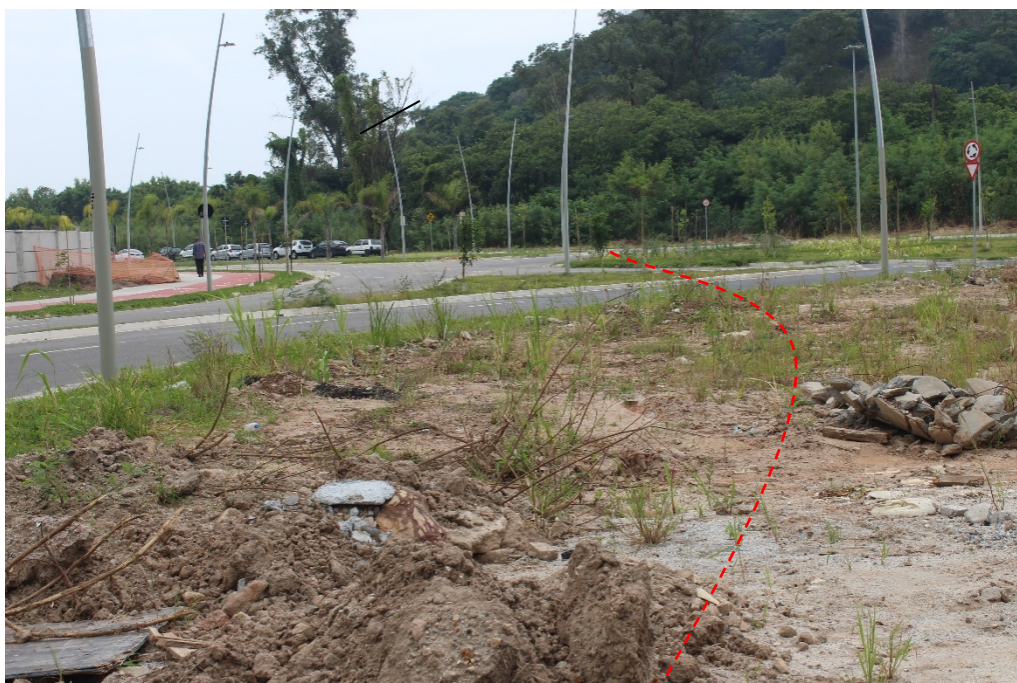
Foto 4: Trecho de expansão da rede de gás.
