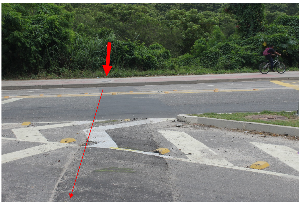
Foto 1: Ponto de início da obra (Travessia de rede por método destrutivo).
