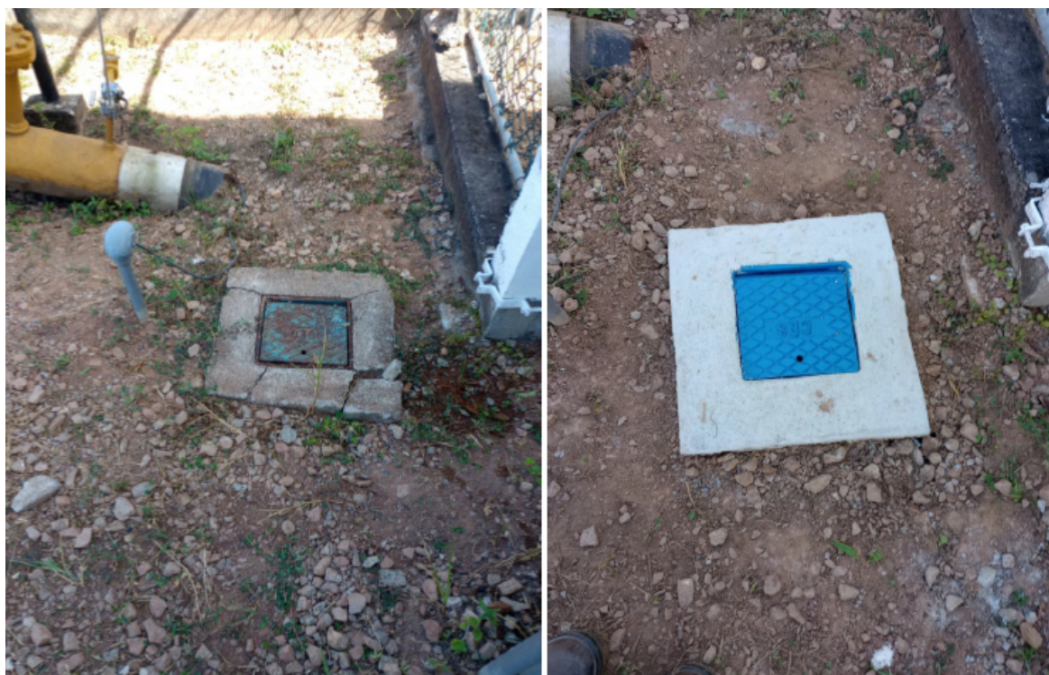
Foto 8: Concretagem da caixa de proteção catódica (antes e depois)
