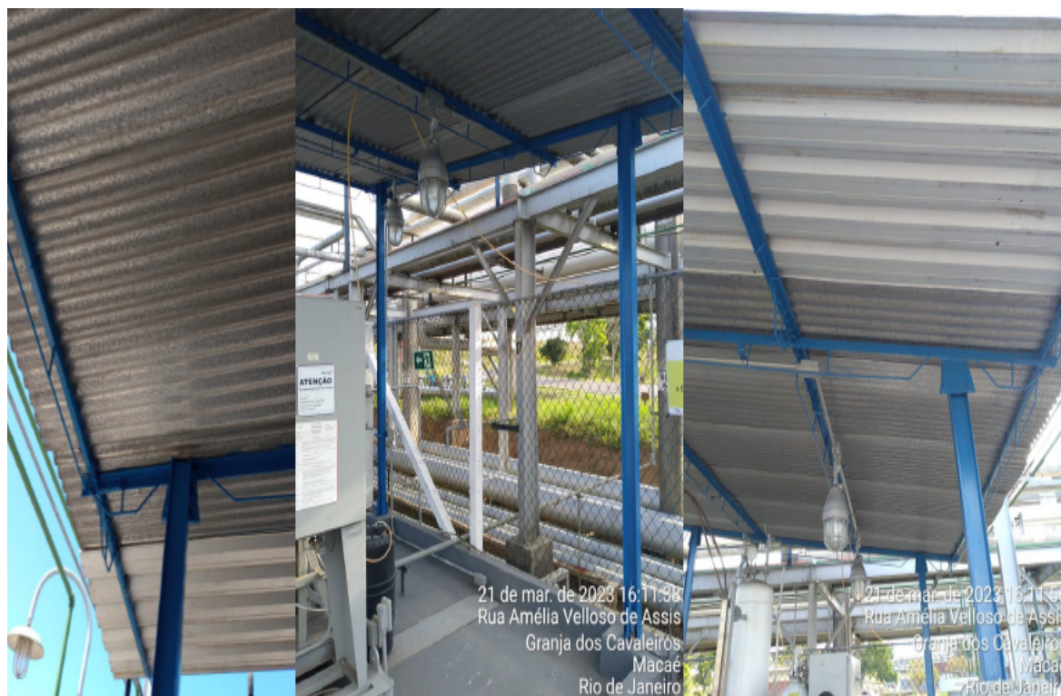
Foto 5: Pintura da estrutura do telhado (antes e depois)
