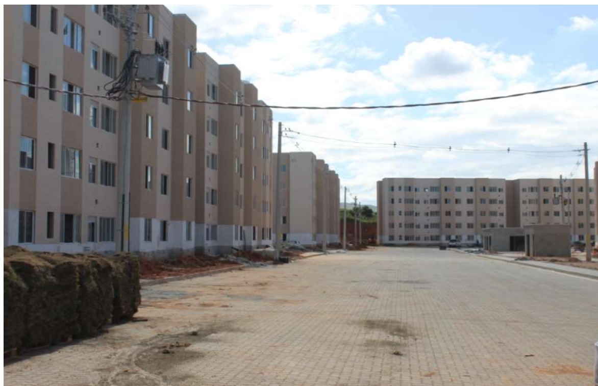
Foto 2 : situação atual das obras do condomínio
