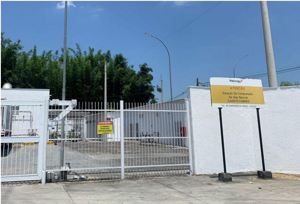
Foto 1: Placa de identificação da estação.
