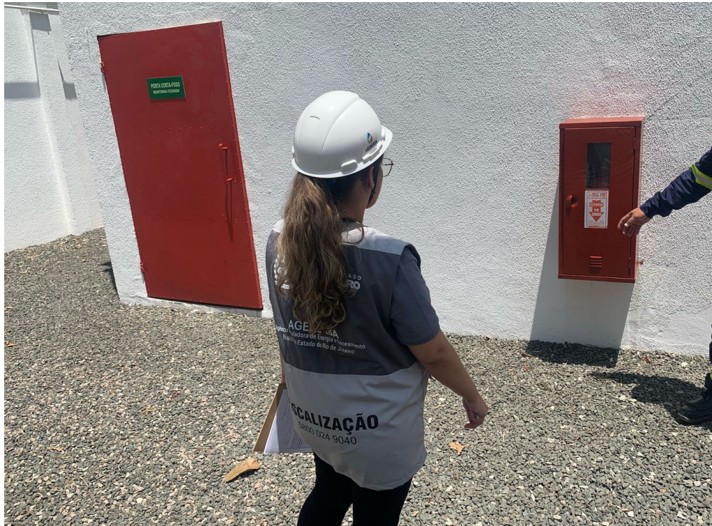
Foto 9: Verificação dos extintores.
