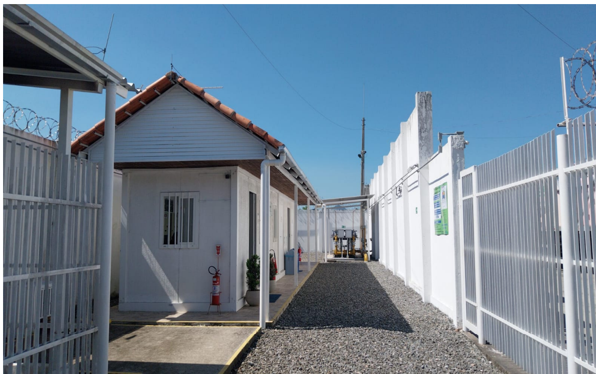
Foto 3: Sala de operação e controle, copa e baheiro
