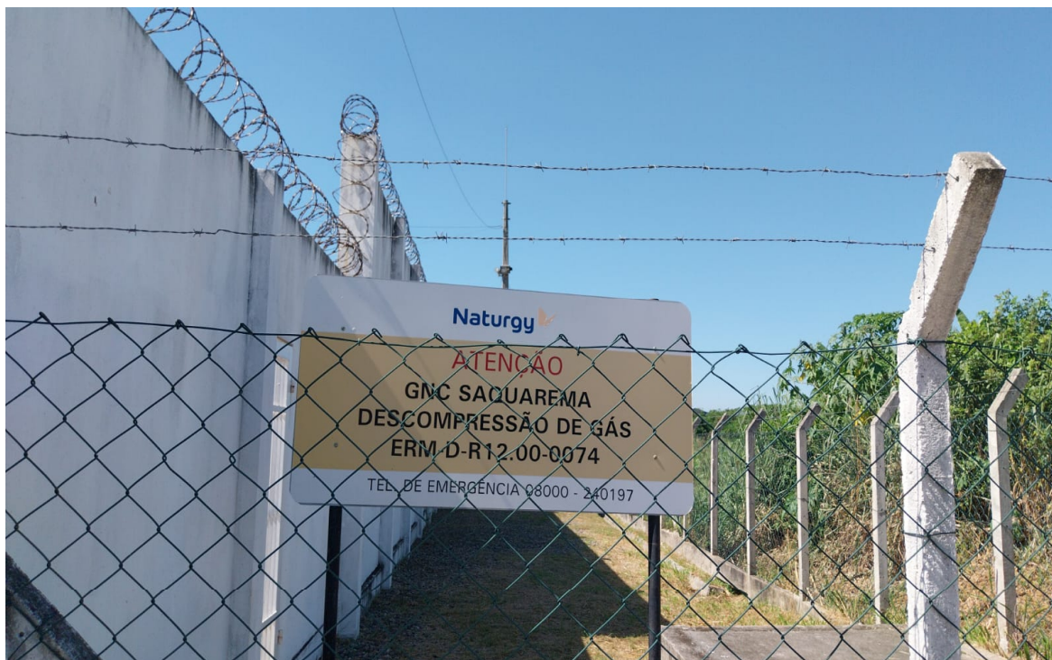
Foto 1: Placa de identificação da estação
