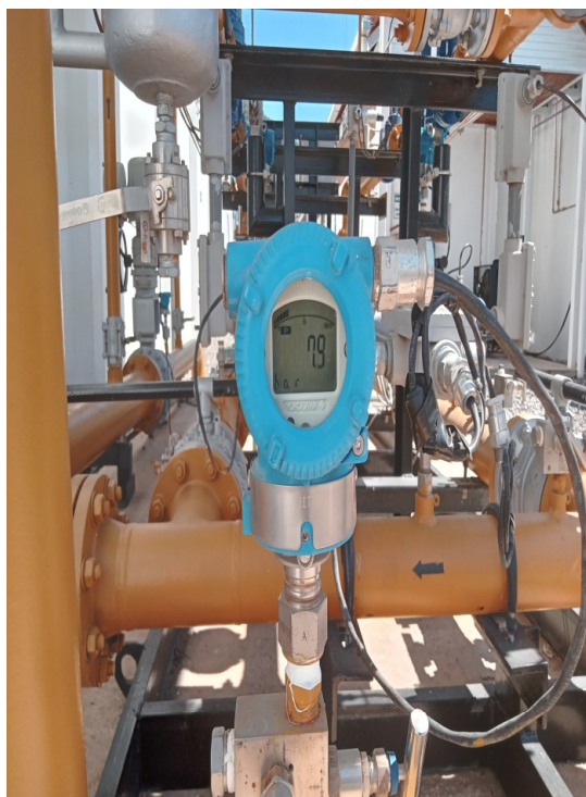
Foto 11: Medição da pressão de entrada
