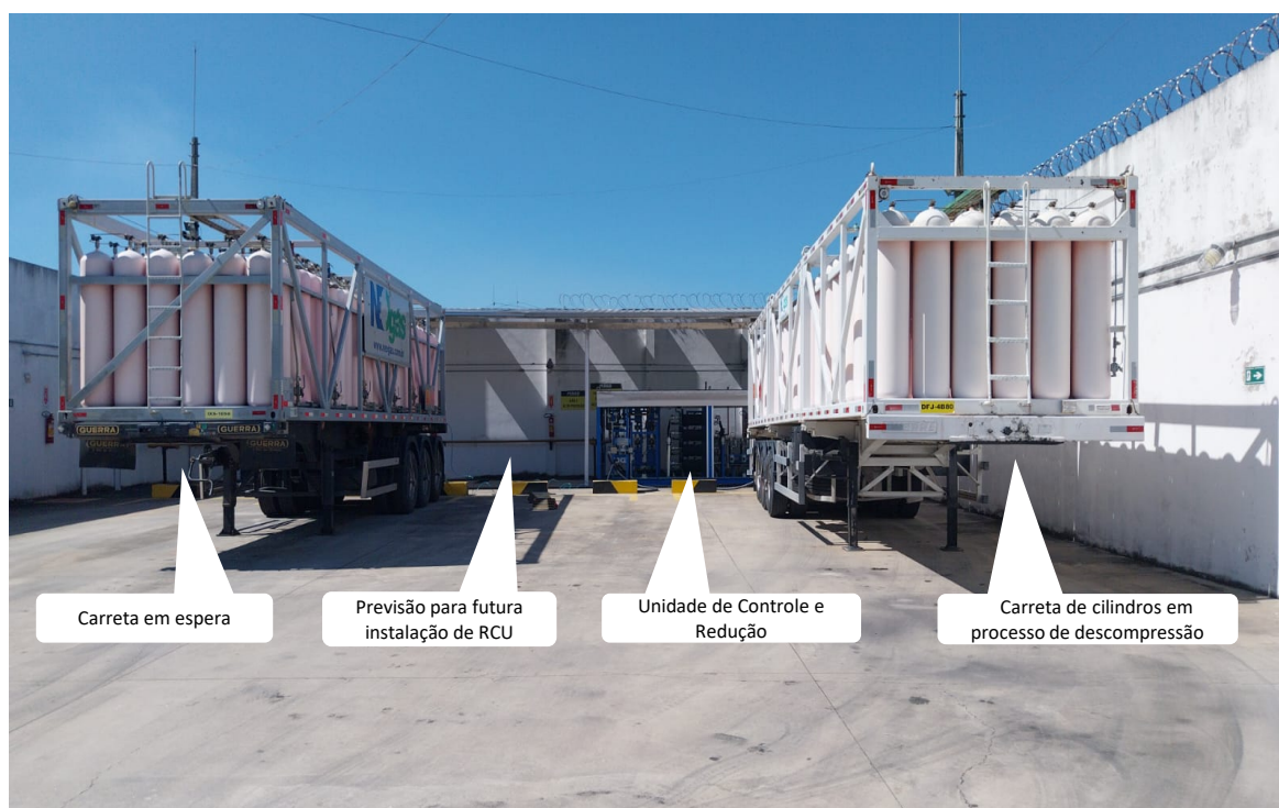
Foto 4: Área de descompressão
