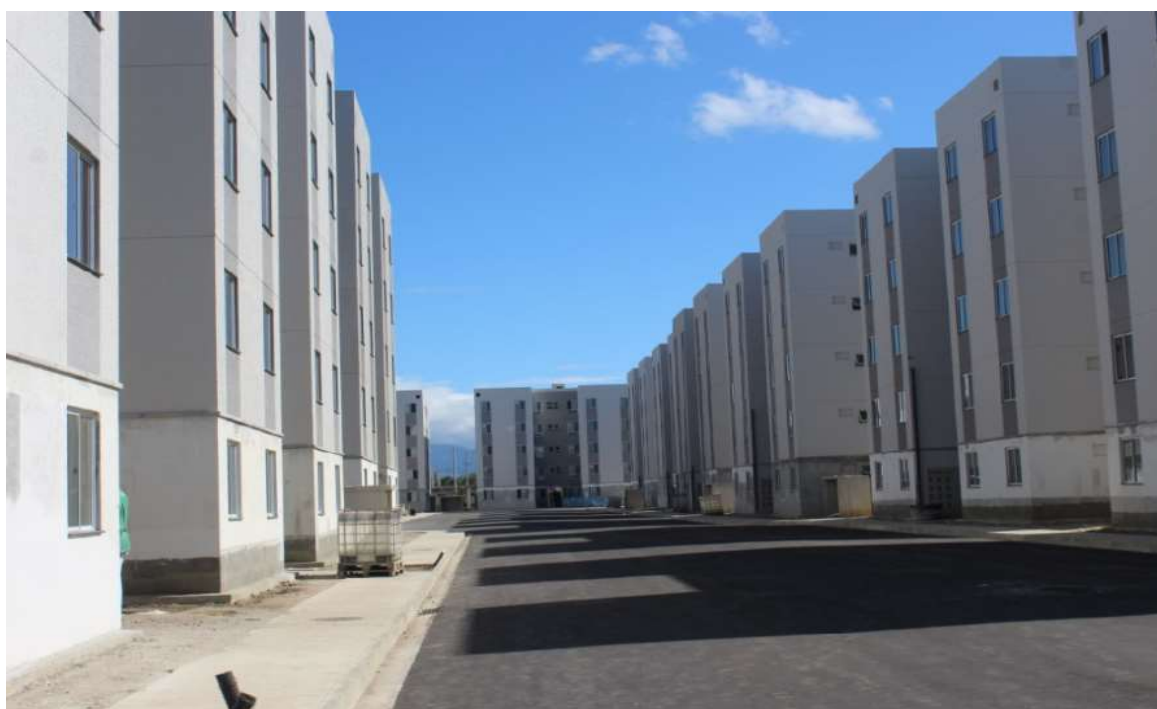
Foto 2 : situação atual das obras do condomínio
