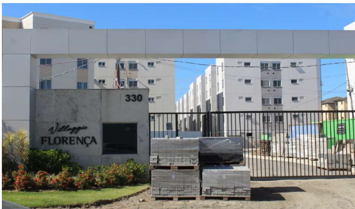
Foto 1 : fachada do condomínio
