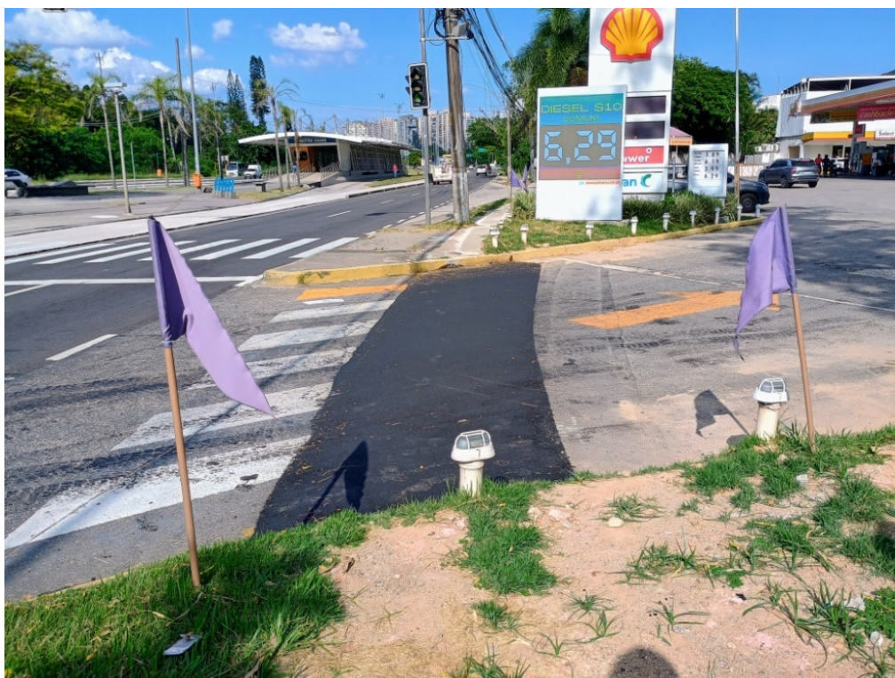
Foto 5: Extensão do trecho entre a Esquina da Estrada Francisco da Cruz Nunes e a Rua José Chineli e o Posto a ser atendido – método não destrutivo.
