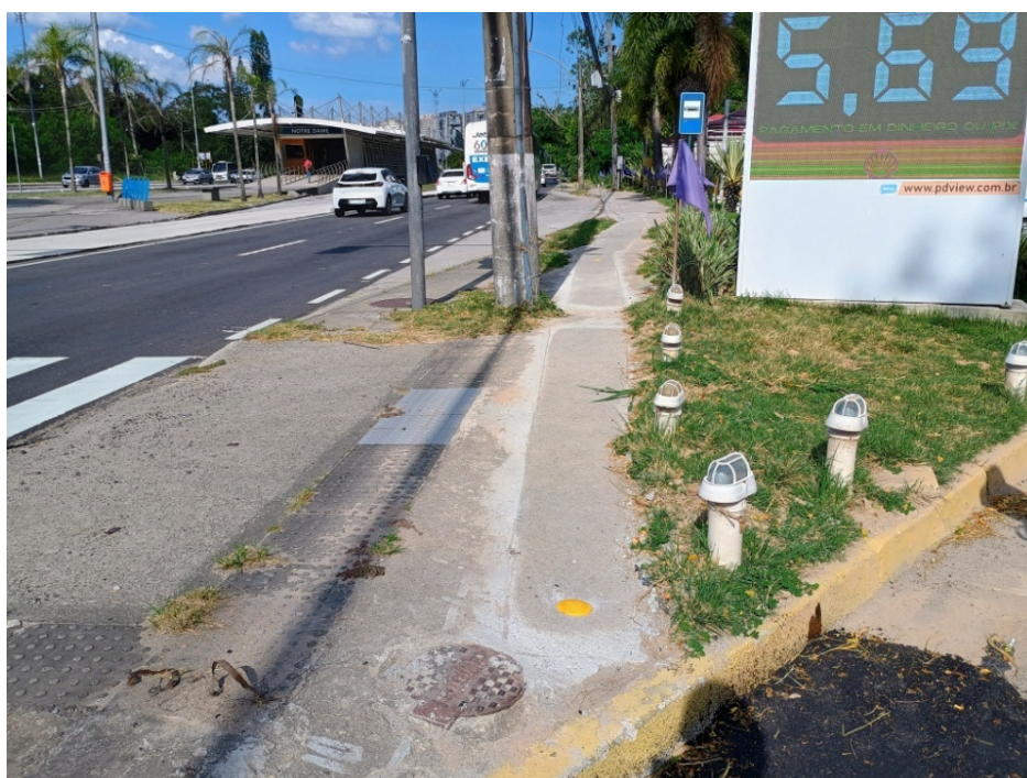
Foto 6: Extensão do trecho entre a Esquina da Estrada Francisco da Cruz Nunes e a Rua José Chineli e o Posto a ser atendido – método não destrutivo.
