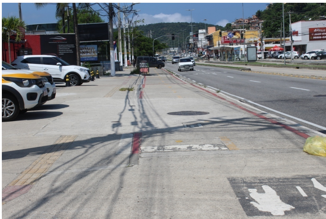
Foto 12: Ponto entre a esquina da Estrada Francisco da Cruz Nunes (lado ímpar) e a R. José Chianeli até a conexão na linha existente, será executado com tubulação de PE de Ø160 mm por meio destrutivo
