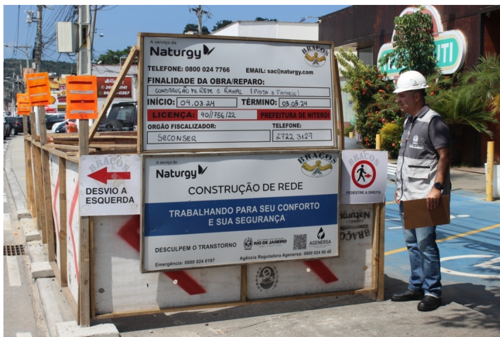
Foto 3: Início do trecho entre a Esquina da Estrada Francisco da Cruz Nunes e a Rua José Chineli e o Posto a ser atendido – método não destrutivo.
