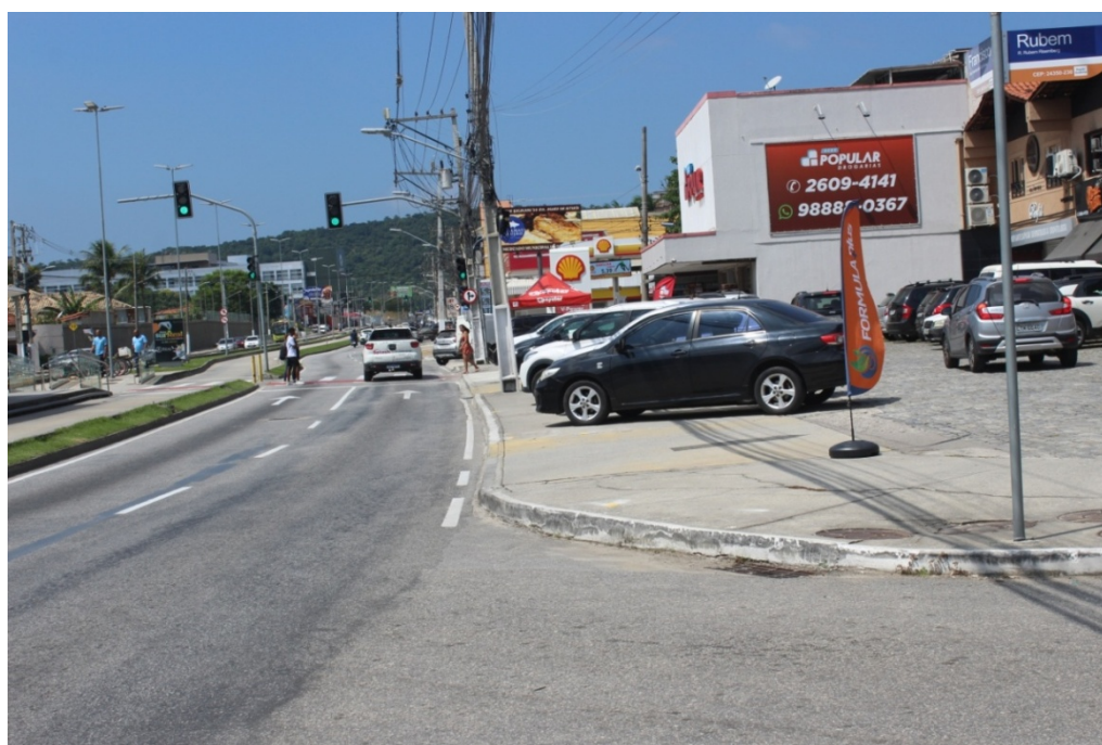
Foto 4: Extensão do trecho entre a Esquina da Estrada Francisco da Cruz Nunes e a Rua José Chineli e o Posto a ser atendido – método não destrutivo.
