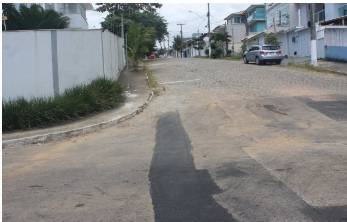
Foto 6: Recomposição de trecho em cruzamento de pista
