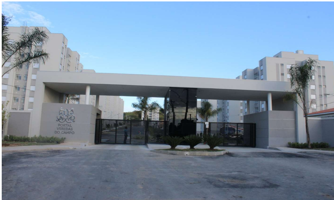
Foto 1 : Entrada do conjunto habitacional
