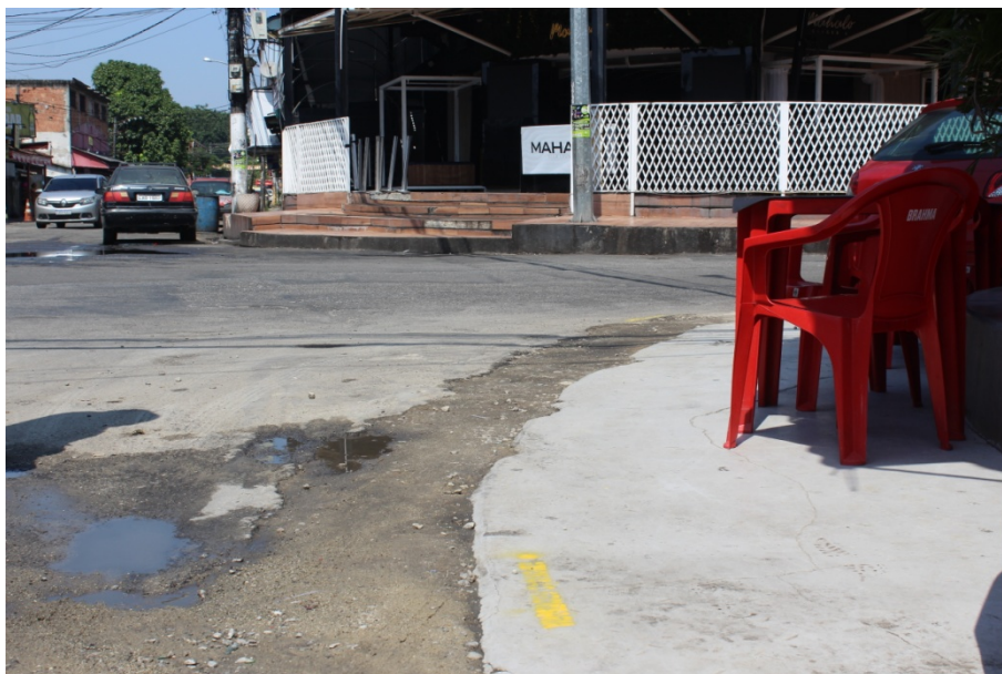
Foto 3: Trecho realizado por método destrutivo.
