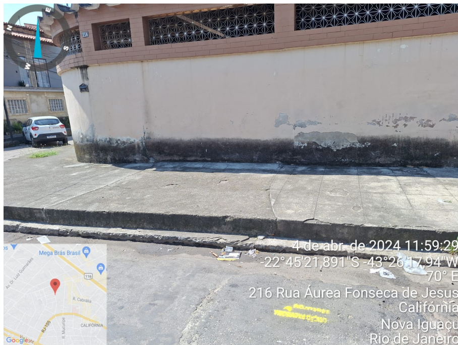
Foto 12: Pintura realizada identificando recomposição provisória.
