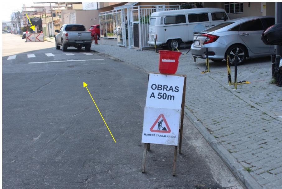
Foto 2: Trecho que resta para concluir (isolamento de obra com ponta de rede parada)
