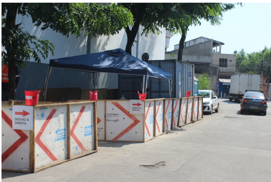
Foto 10: Área de vivência, armazenamento de materiais e banheiro químico.
