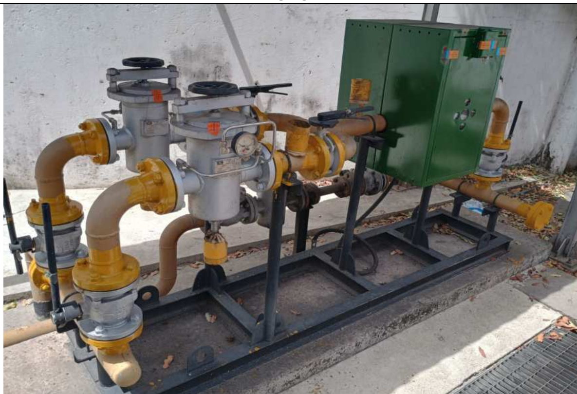
Foto 6: estação de medição do posto Petrobras.
