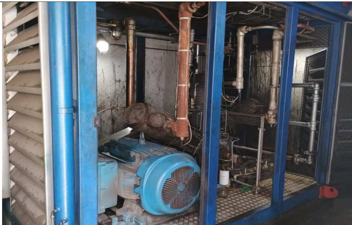
Foto 3: compressor do posto Rotor.
