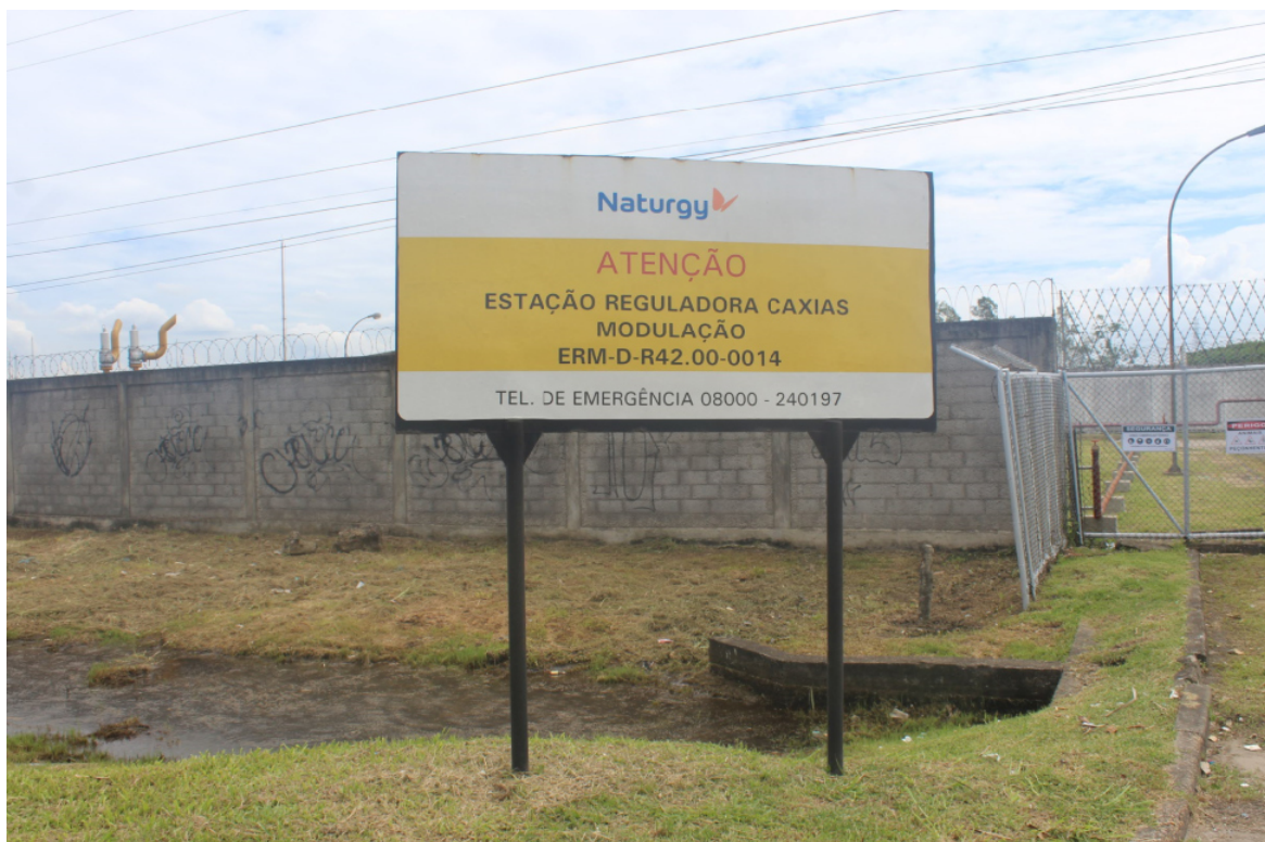
Foto 1: Placa de identificação da Estação
