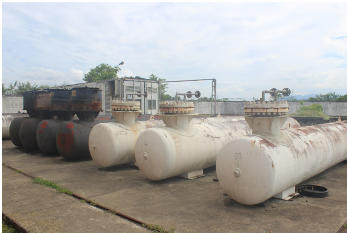
Foto 14: Tanques de GLP dispostos ao final da estação
