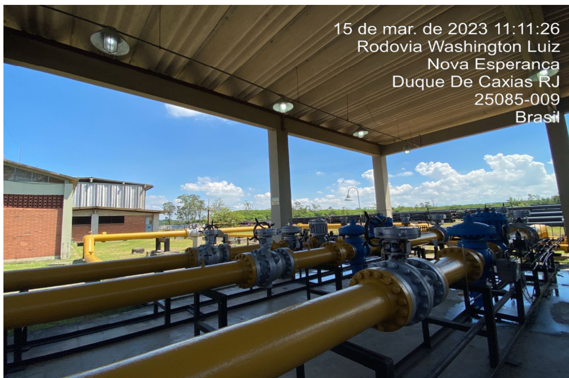
Foto 9: Sistema de iluminação operante
