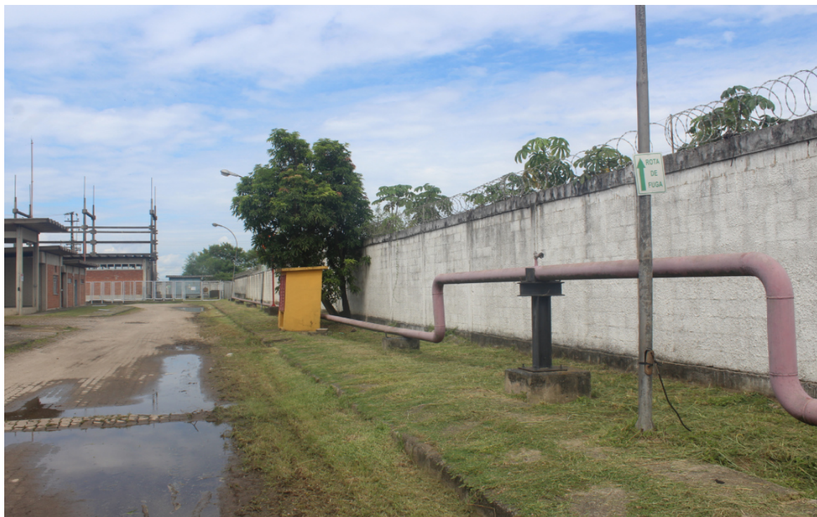
Foto 11: Ausência/insuficiência de placas de rota de fuga
