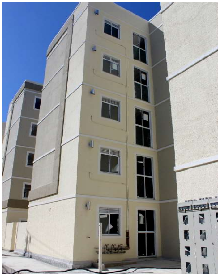
Foto 4 : Instalações internas preparadas para receber os reguladores e os medidores
