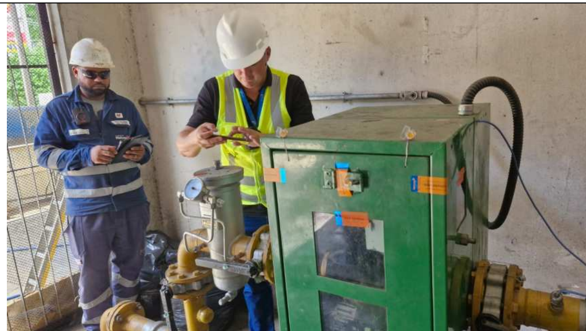
Foto 6: Equipe técnica da Concessionária e da terceirizada realizando inspeção nos lacres.
