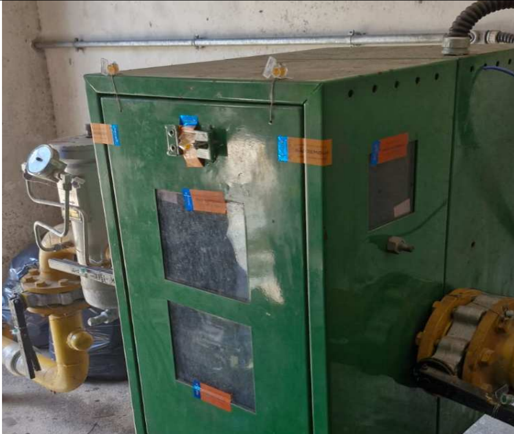
Foto 4: Estação de medição, destaque para a caixa de proteção do medidor e os lacres ao redor.
