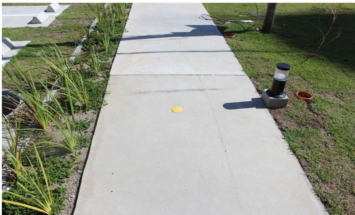
Foto 4 : Marco plano sinalizando a existência de rede de gás natural.
