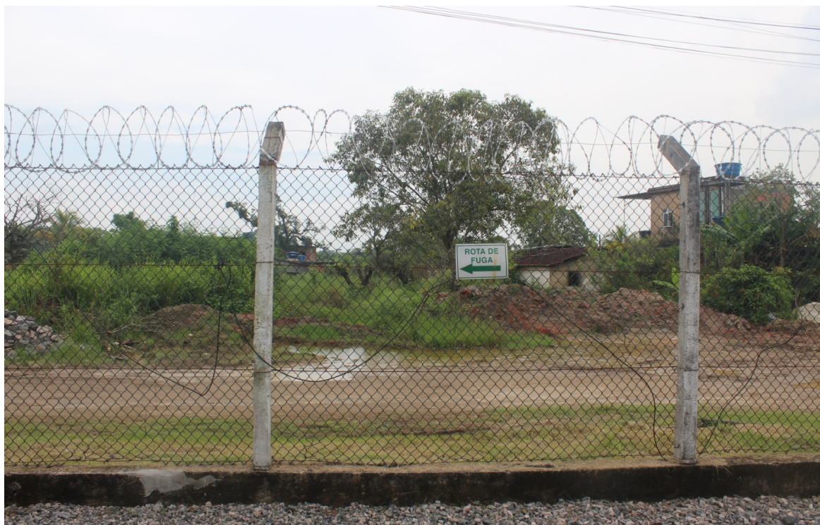
Foto 15: Sinalização de rota de fuga
