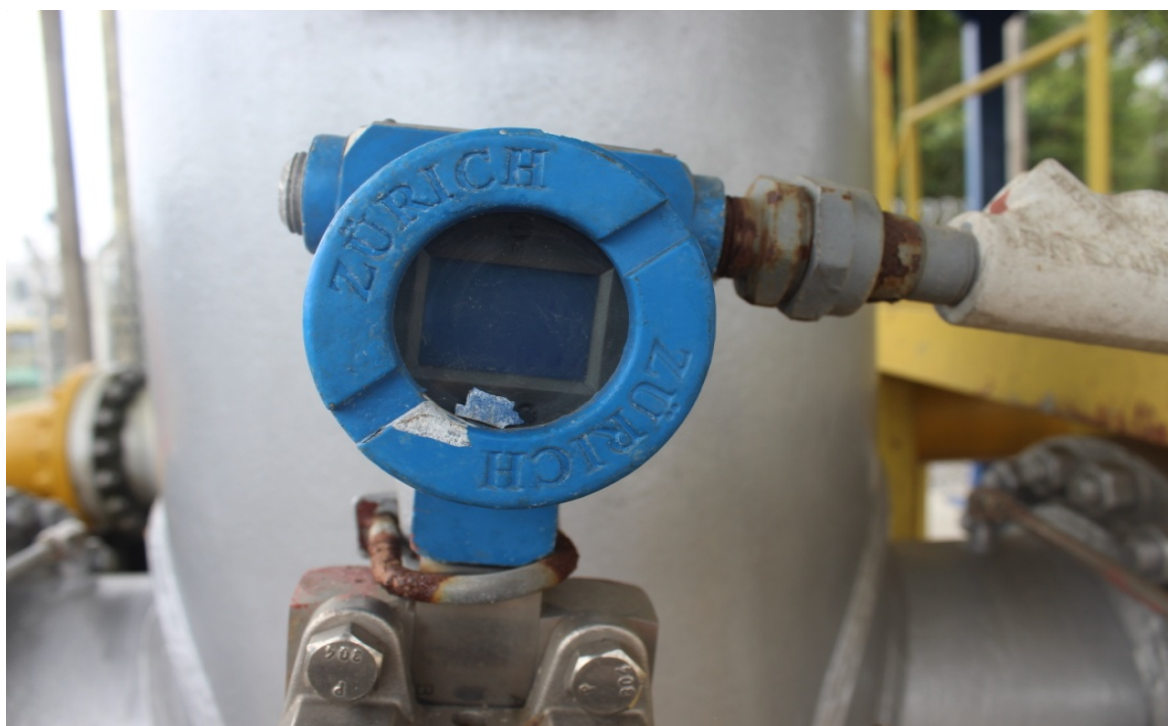
Foto 12: Medidor de pressão com display inativo
