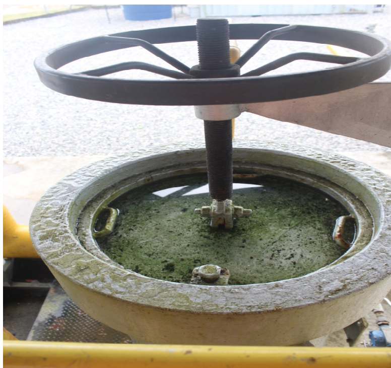
Foto 13: Água acumulada na parte superior do filtro
