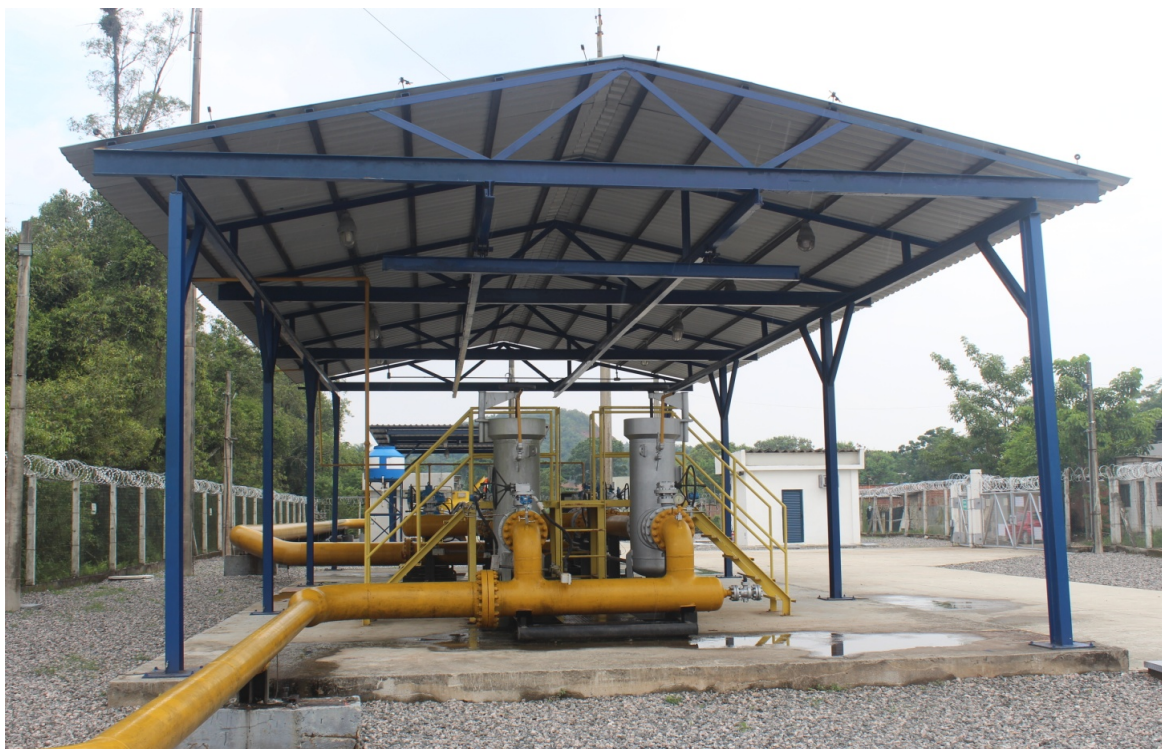
Foto 4: Cobertura da estação
