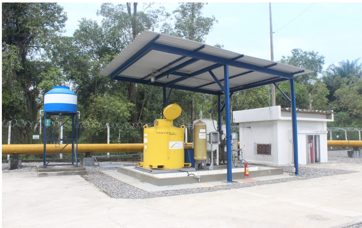
Foto 5: Sistema de odorização - sala de cromatografia
