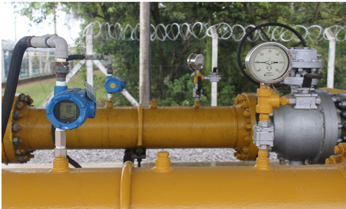
Foto 7: Manômetro anterior ao regulador indicando pressão abaixo do valor de saída
