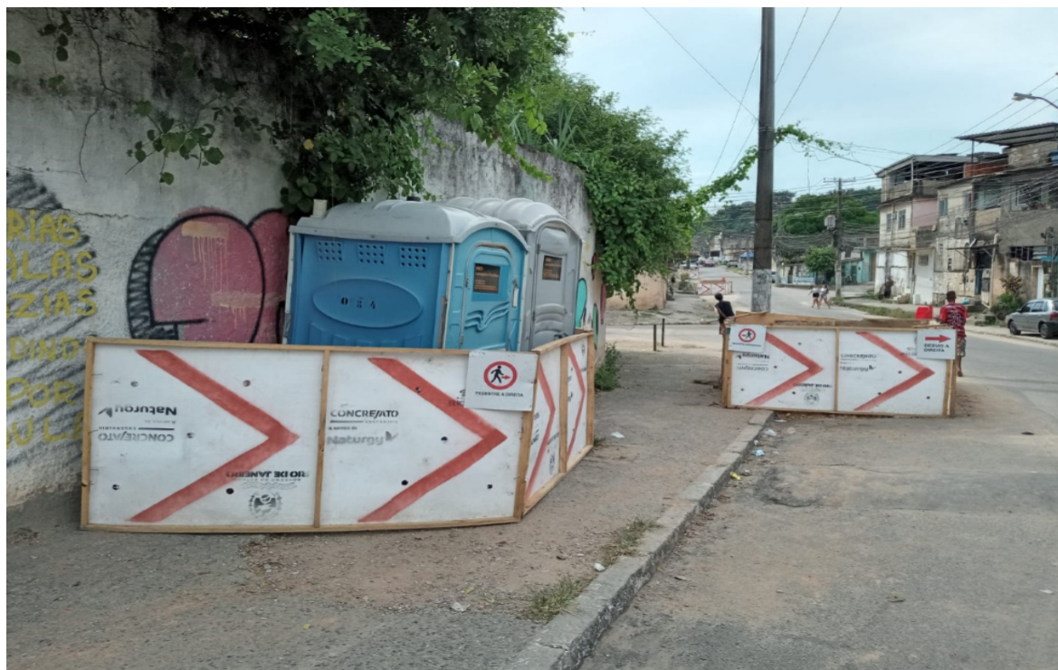
Foto 9: Sinalização de desvio de obra
