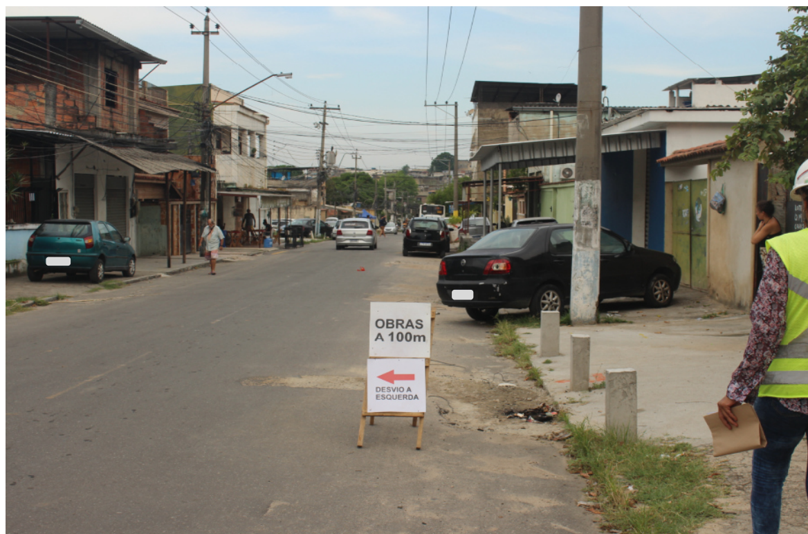
Foto 5: Aviso de obra à frente
