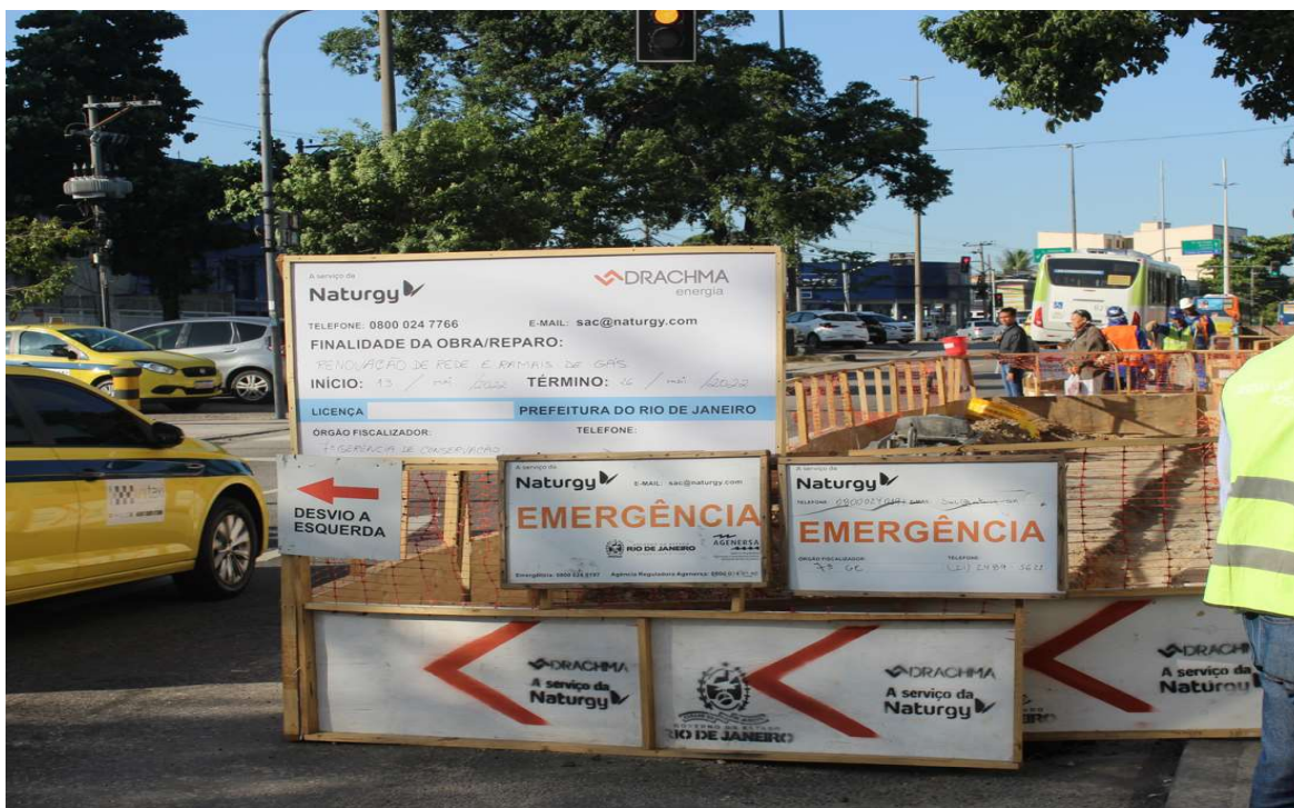
Foto 1 : renovação e expansão de rede na Av. Dom Hélder Câmara
