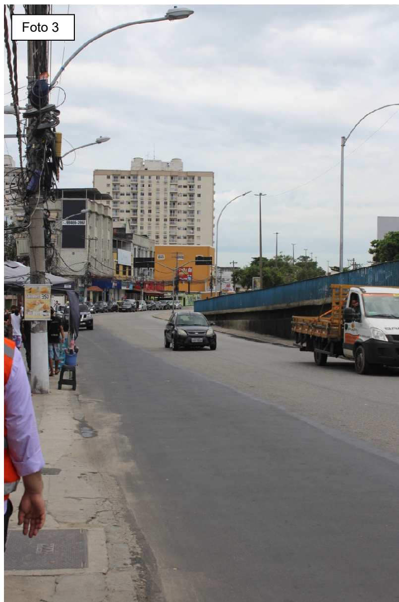
Foto 3: visibilidade do asfaltamento da Avenida, do nº 3378 ao nº 3366
