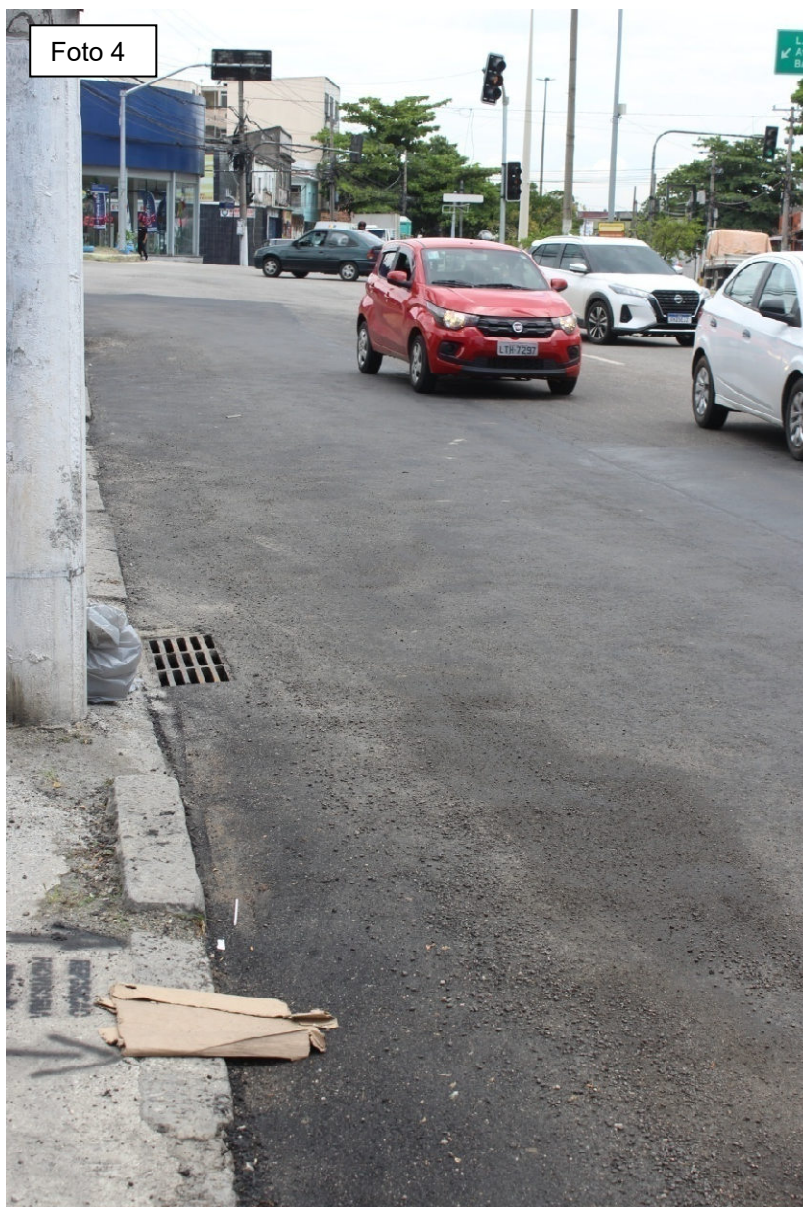
Foto 4: reposição provisória e asfaltamento em frente ao nº 3136
