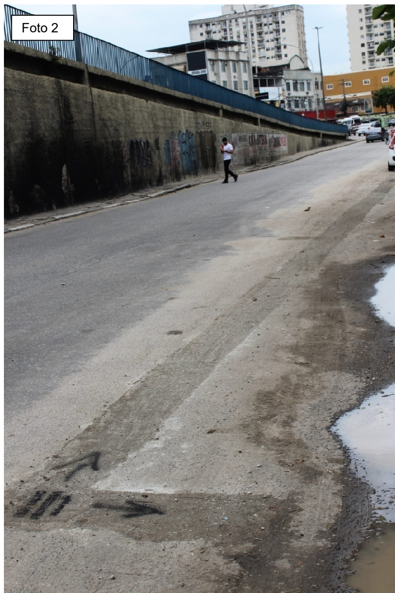
Foto 2: asfaltamento provisório no nº 3443
