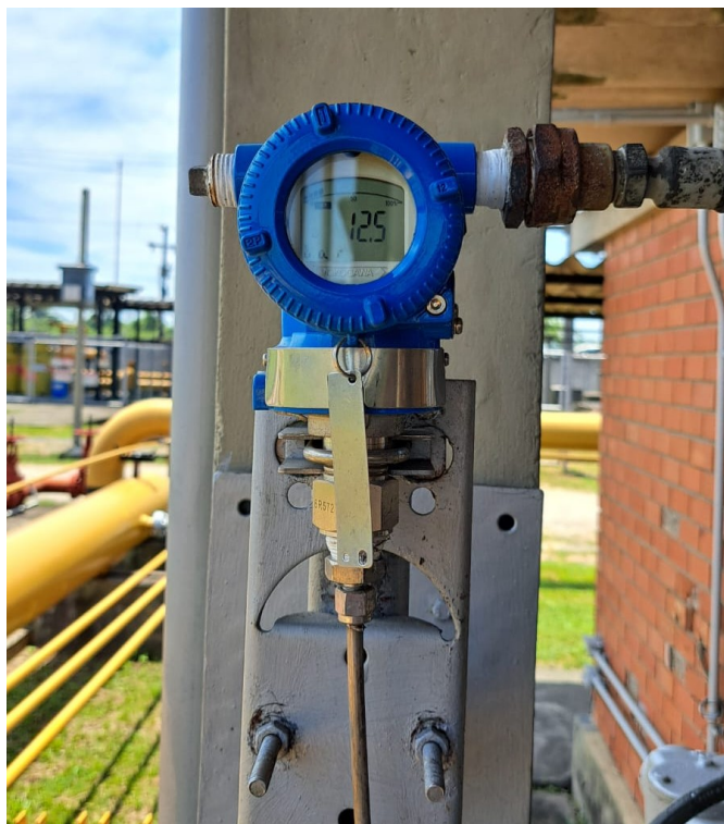
Foto 11: Medidor da pressão de saída.
