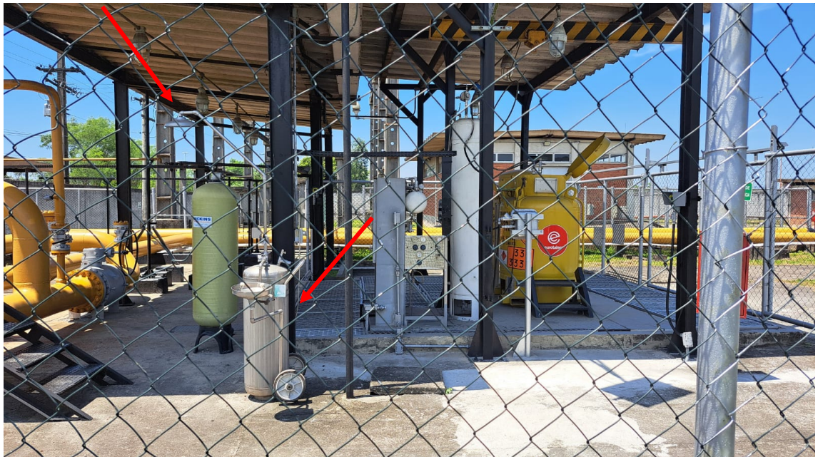
Foto 4: Chuveiro e lava olhos para casos de contaminação por mercaptana localizado dentro da área do Sistema de Odorização.
