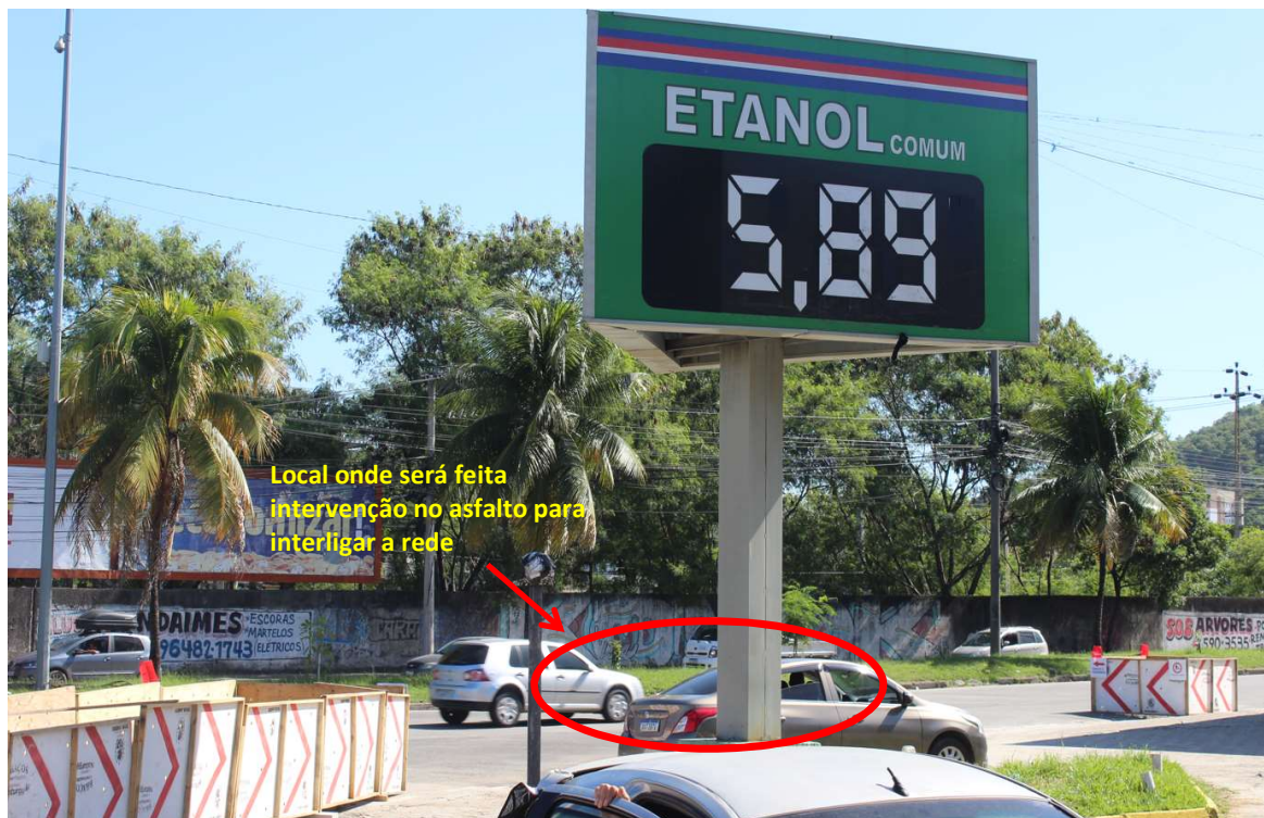
Foto 6 : interligação da expansão com a rede
