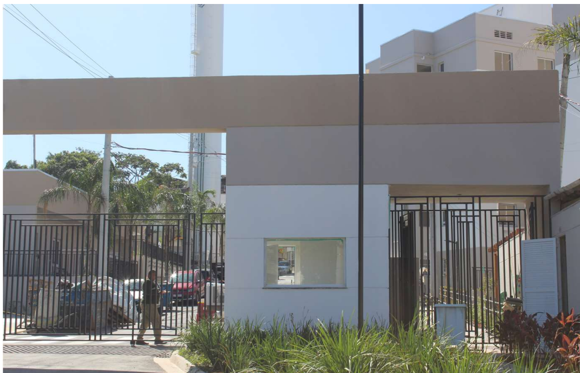
Foto 2 : fachada do residencial
