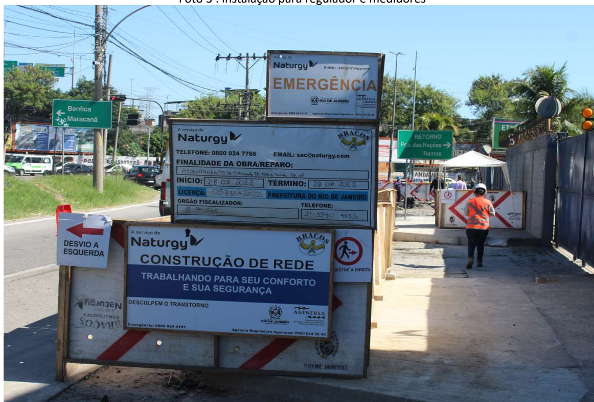
Foto 4 : sinalização da obra de expansão
