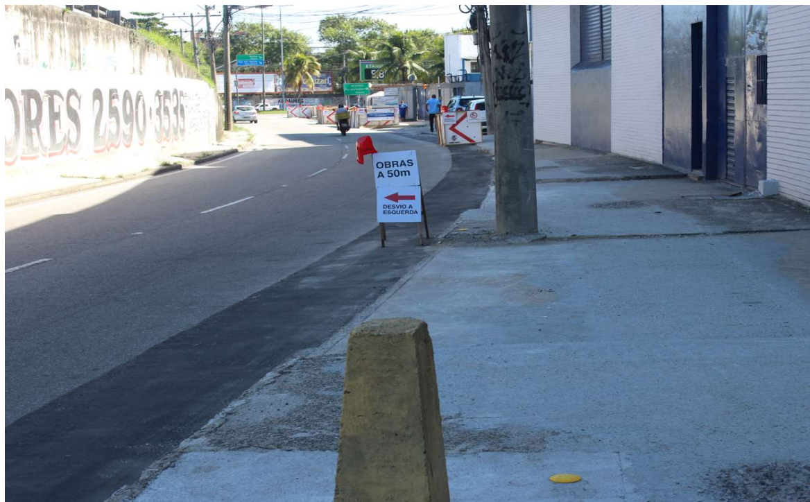
Foto 5 : recomposição de asfalto após obras de expansão
