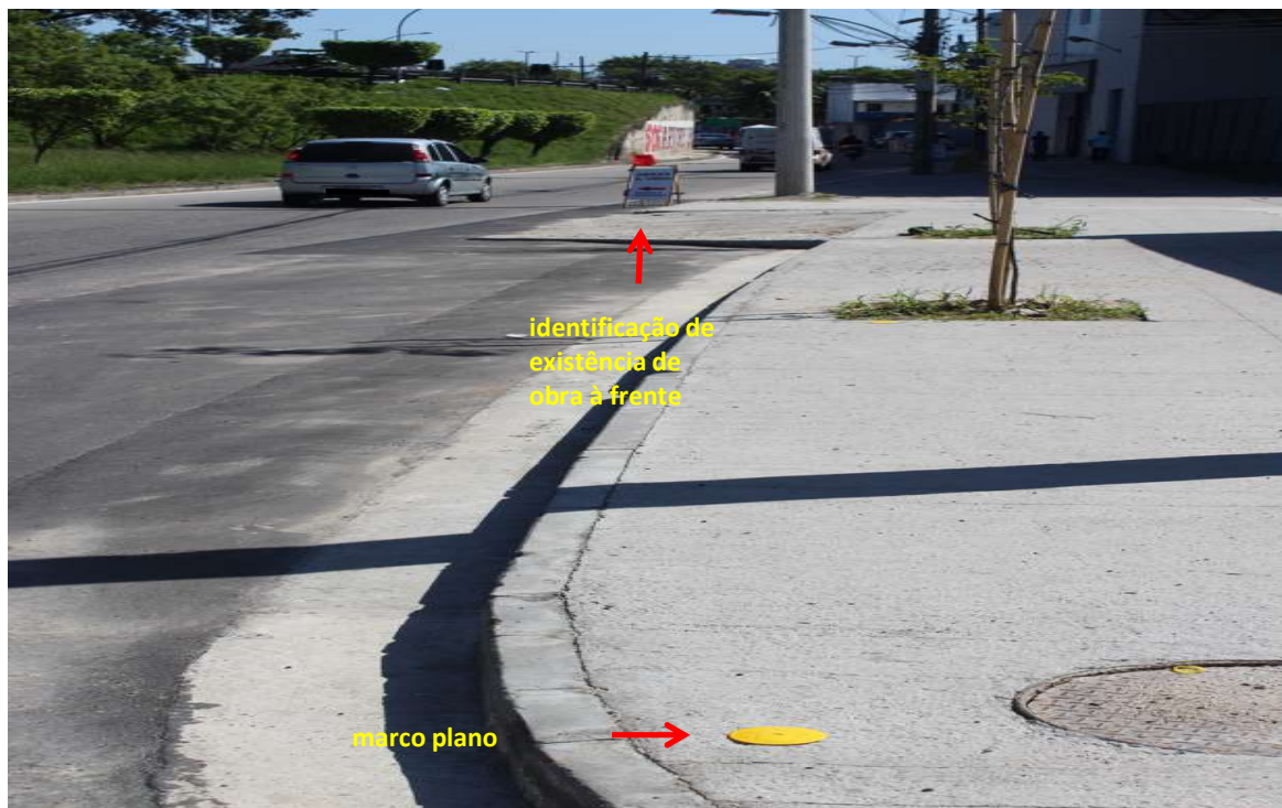
Foto 1 : renovação e expansão de rede na Rua Newton Prado
