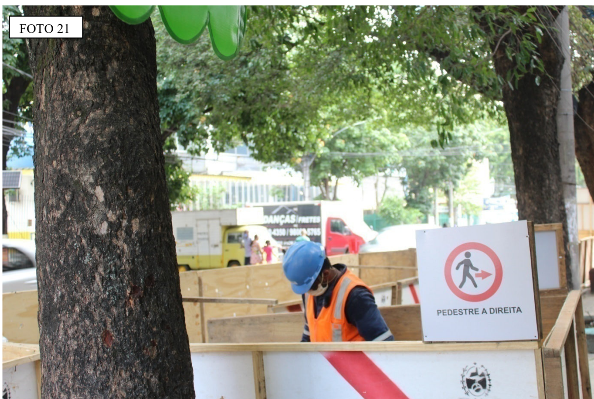
Fotos 20 e 21: tapumes da Concessionária com sinalização de desvio de pedestres.
