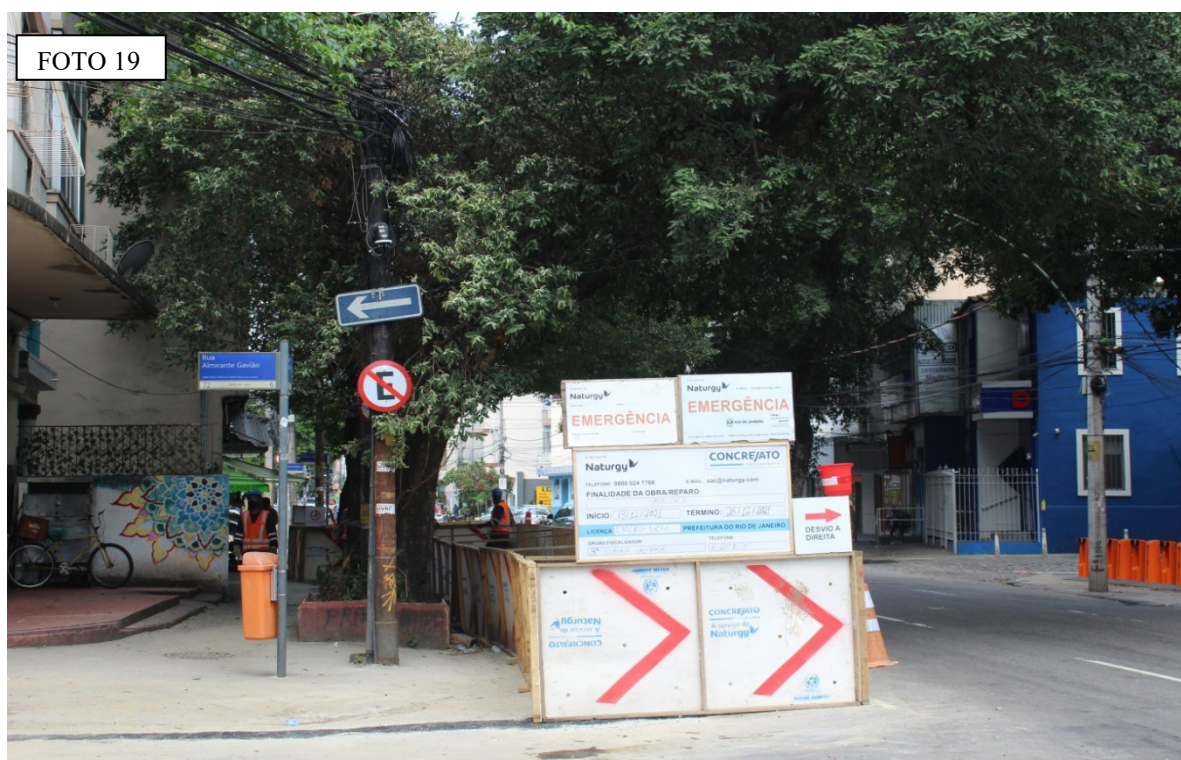
Fotos 18 e 19: tapumes e placas de sinalização da Concessionária
