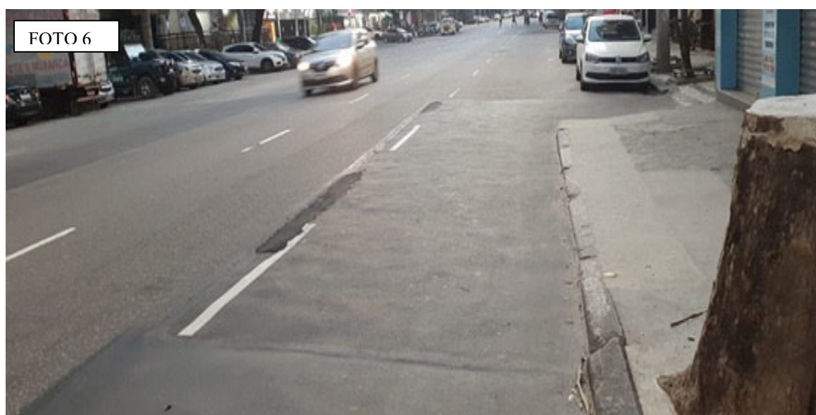
Fotos 5 e 6: asfaltamento da Rua Haddock Lobo com Rua Professor Gabizo – antes e depois
