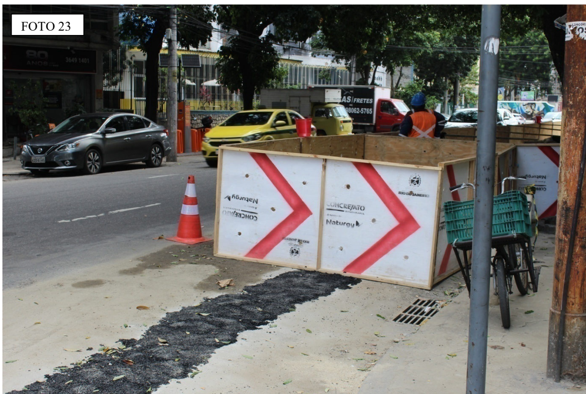
Fotos 22 e 23: cones de sinalização de desvio de trânsito
