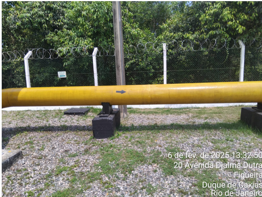
Foto 11: Setas de direção do fluxo repintadas.
