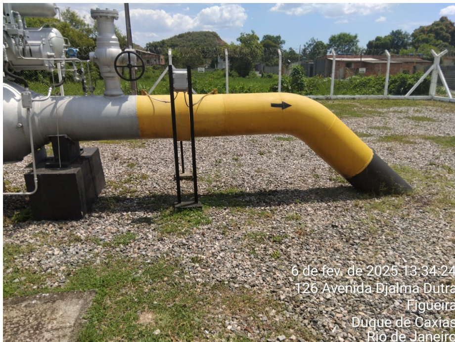
Foto 12: Saída em 20 pol para o ramal metropolitano, com a seta de fluxo repintada.
