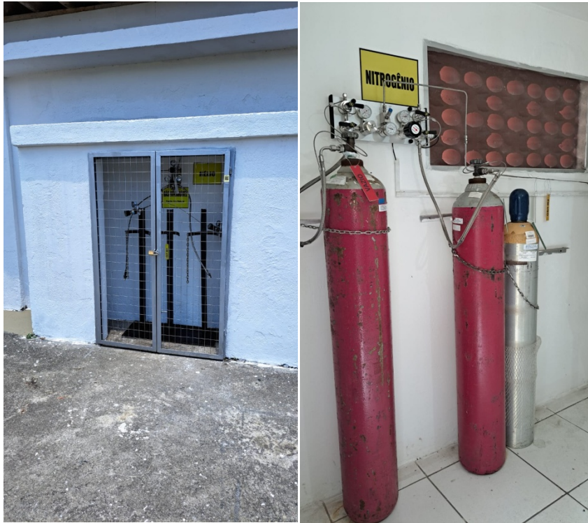
Foto 7: Cilindros remanejados da central externa para dentro da sala de cromatografia.
