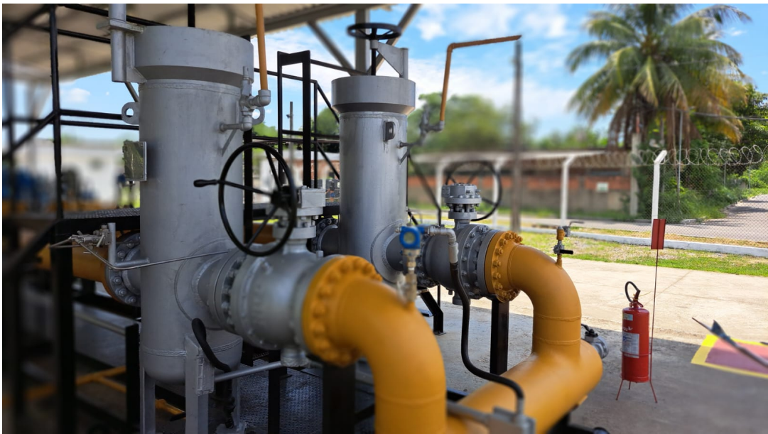
Foto 2: Filtragem antes da regulação da pressão.
