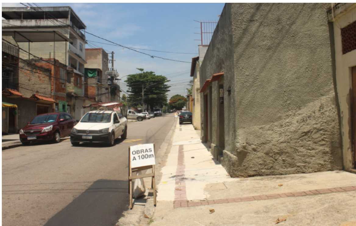
Foto 2: Sinalização de obra à frente e recomposição
