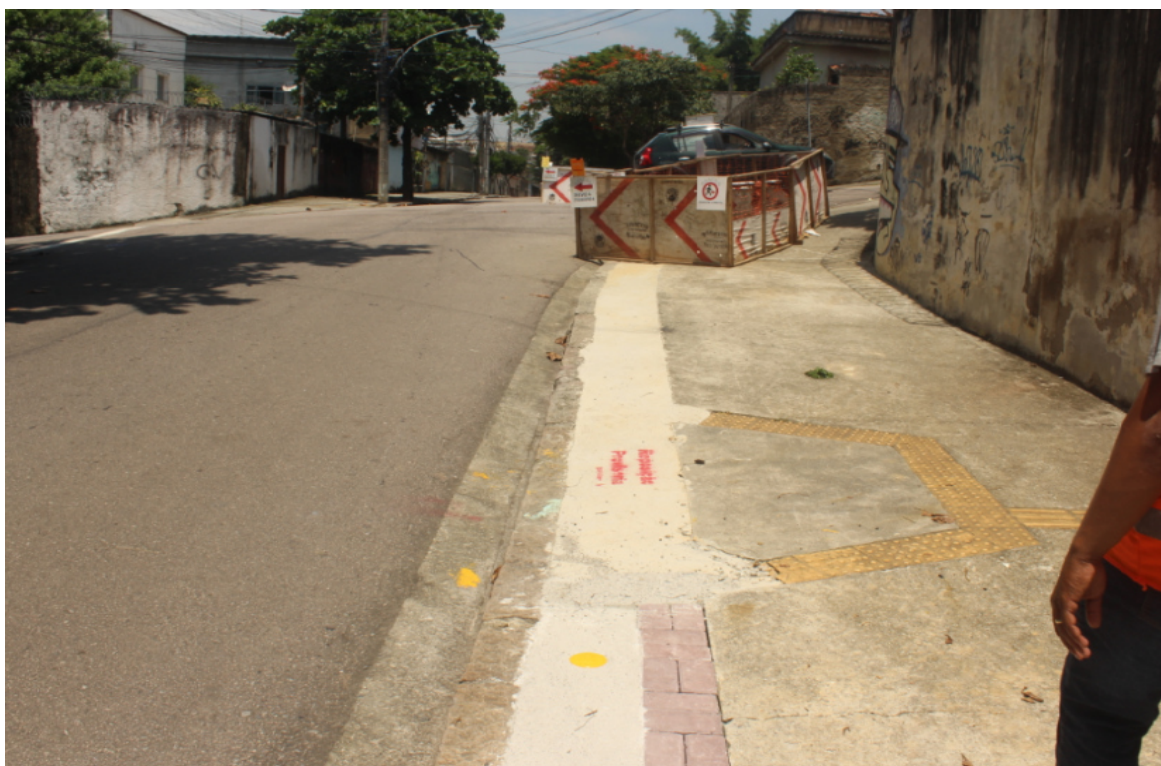
Foto 5: Recomposição provisória e marco plano
