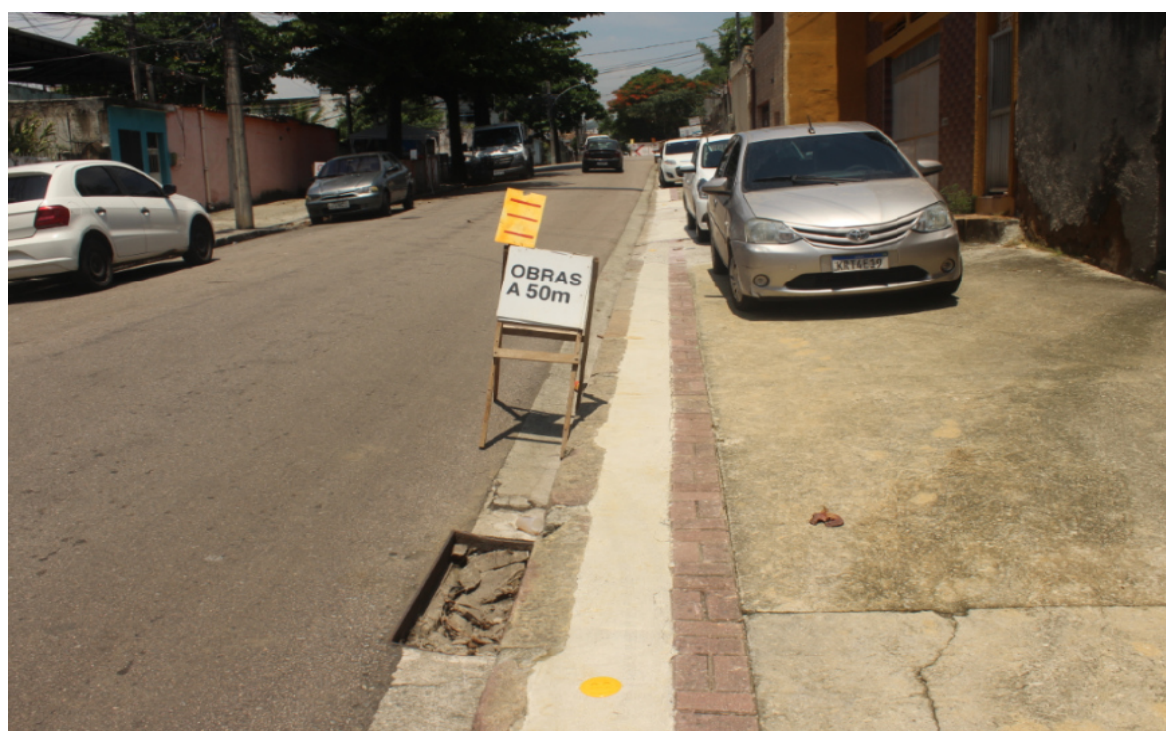
Foto 4: Recomposição, marco plano e sinalização de obra à frente
