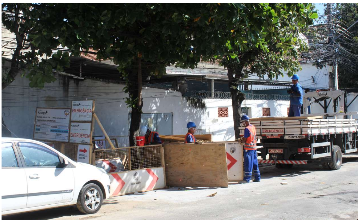
Foto 2 : limpeza e remoção de material
