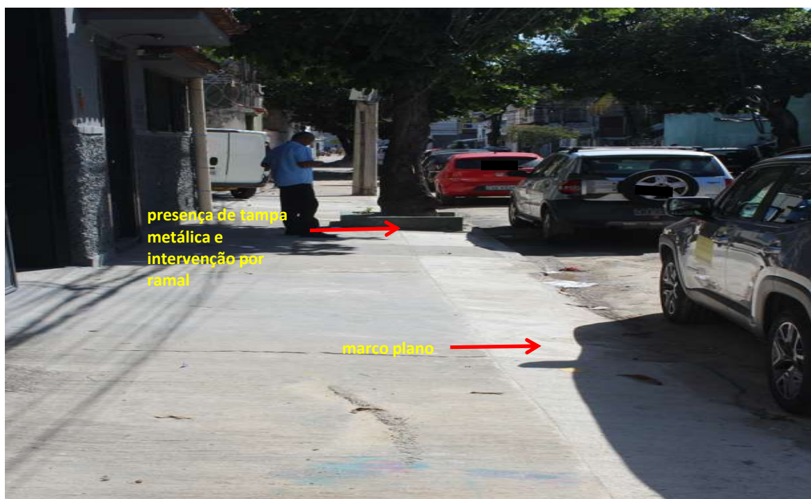
Foto 3 : recomposição da calçada
