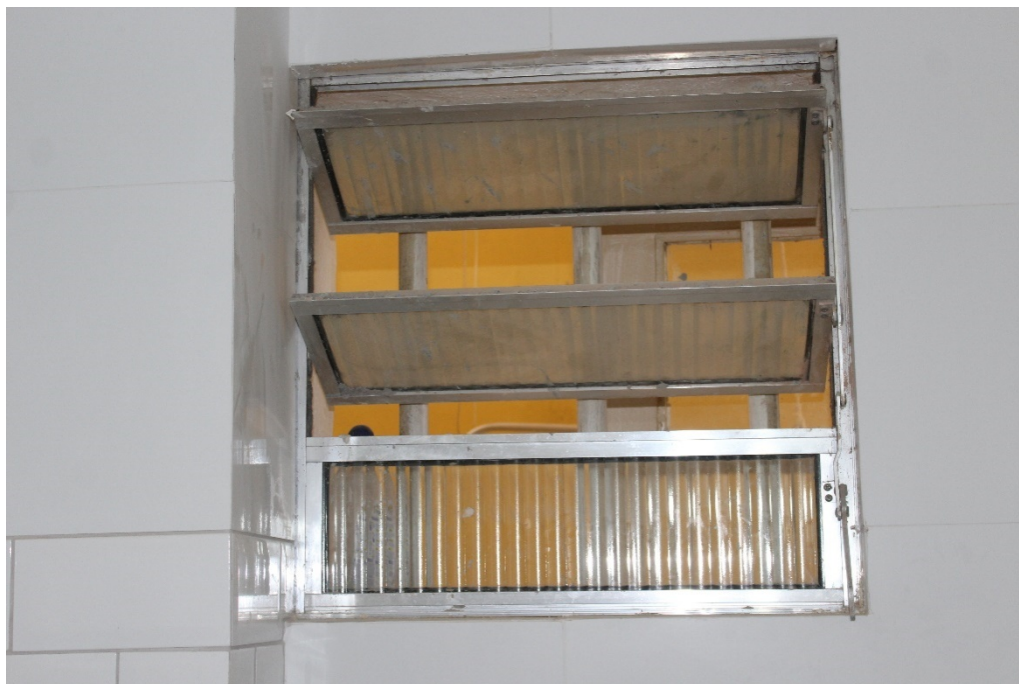
FOTO 9: Basculante da cozinha aberto.
