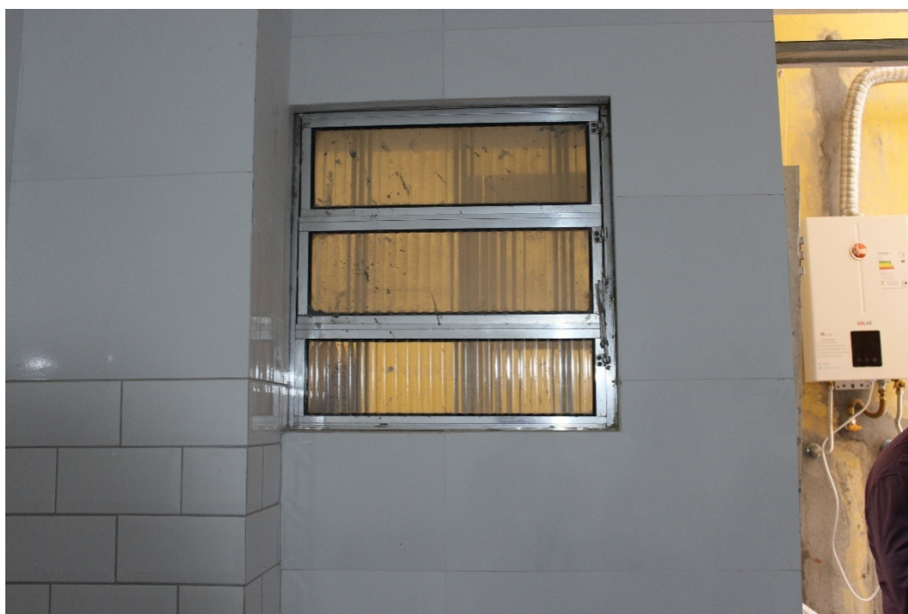
FOTO 10: Basculante da cozinha sem limitador.
