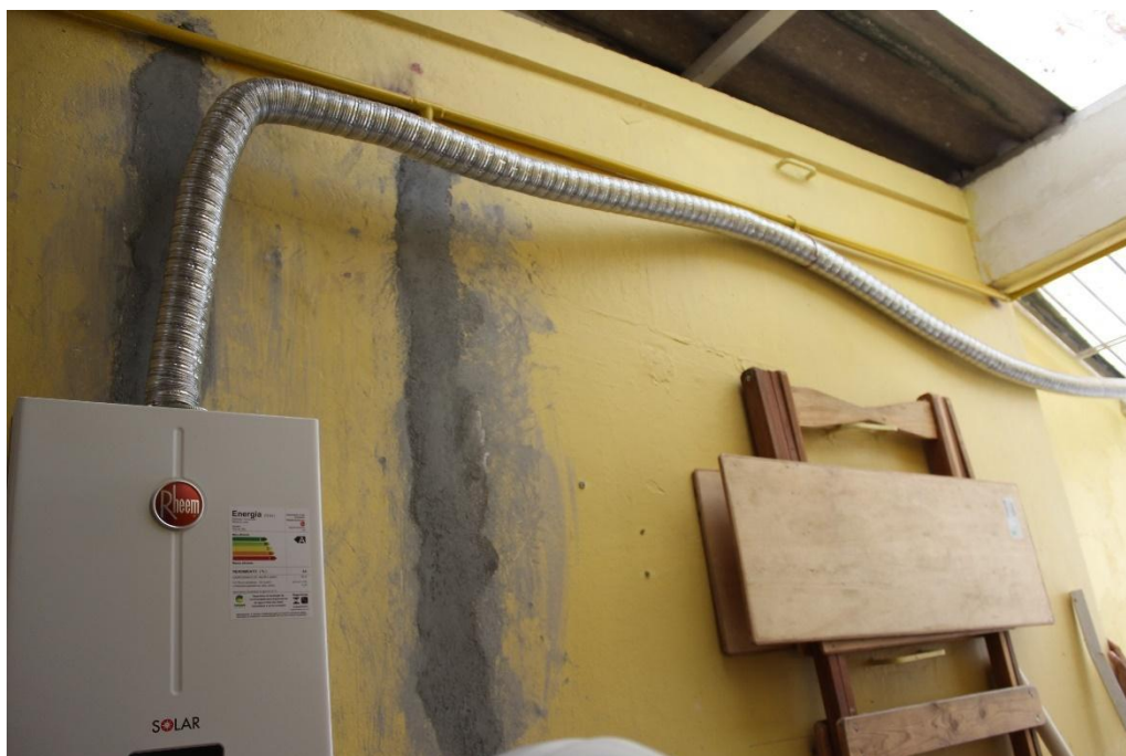
FOTO 11: Tubo flexível de exaustão apresentando oscilações na trajetória de seu percurso.
