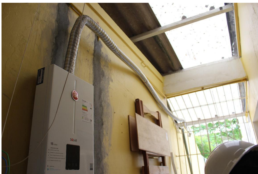
FOTO 12: Tubo flexível de exaustão apresentando oscilações na trajetória de seu percurso.
