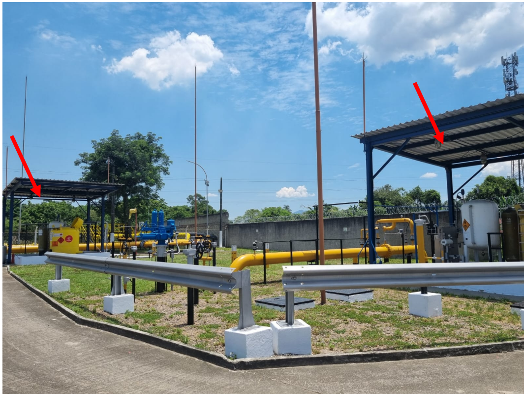
Foto 7: Sistemas de odorização das duas linhas da Estação de Transferência.
