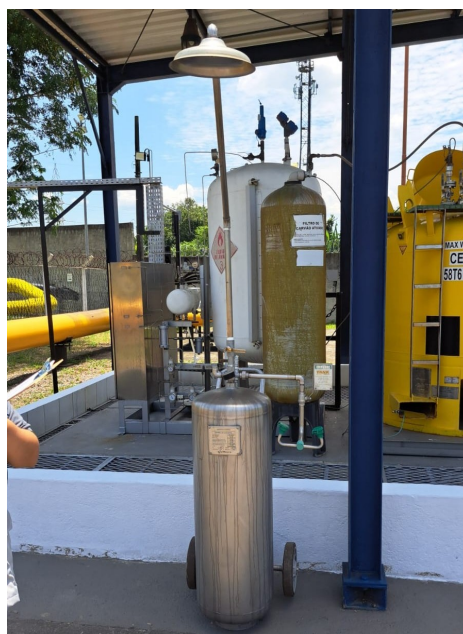
Foto 8: Chuveiro e lava-olhos localizado na estação de odorização da segunda linha. Há também outro desse na primeira linha.
