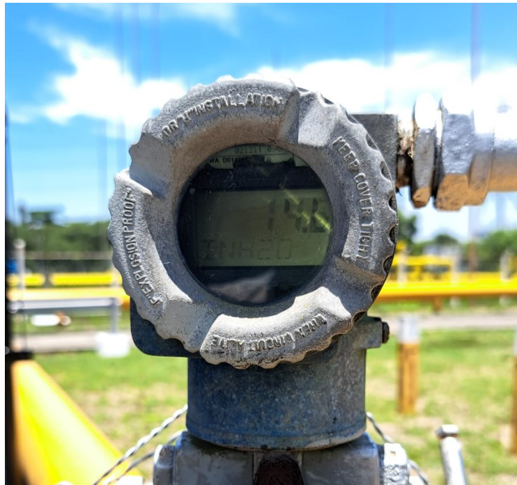
Foto 9: Regulagem da pressão de 40 para 14 BAR na segunda linha para passar pelo processo de odorização.
