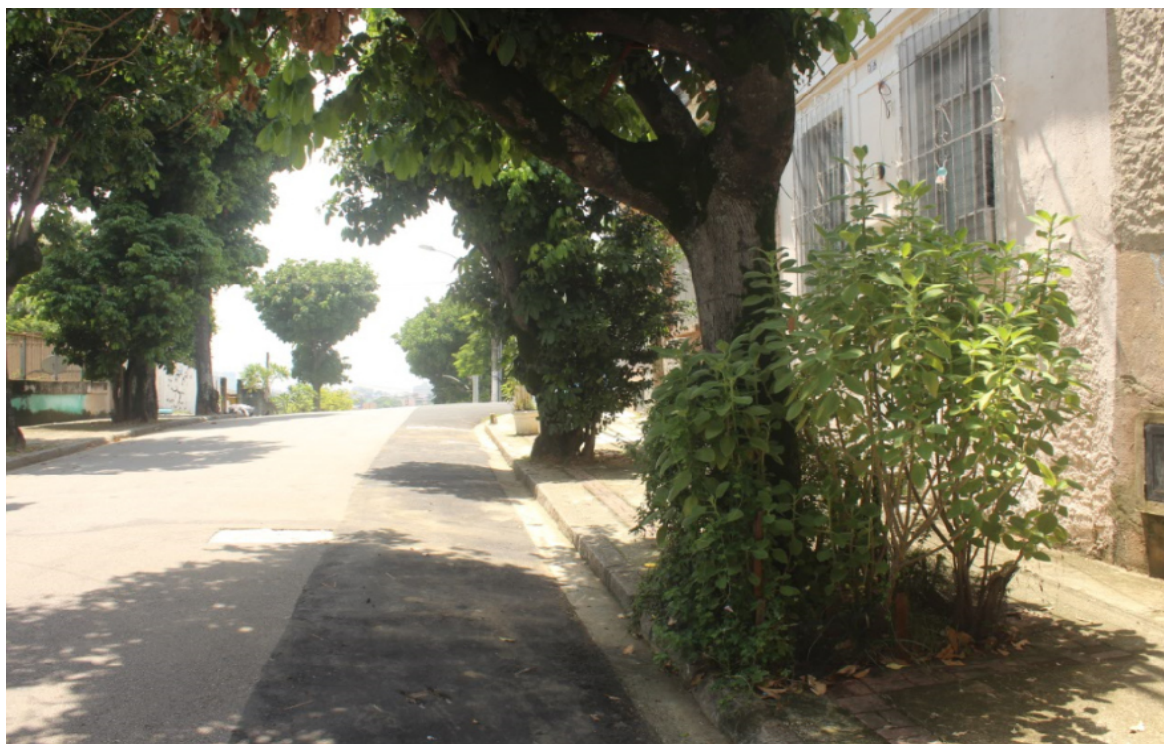
Foto 2: Recomposição insuficiente
