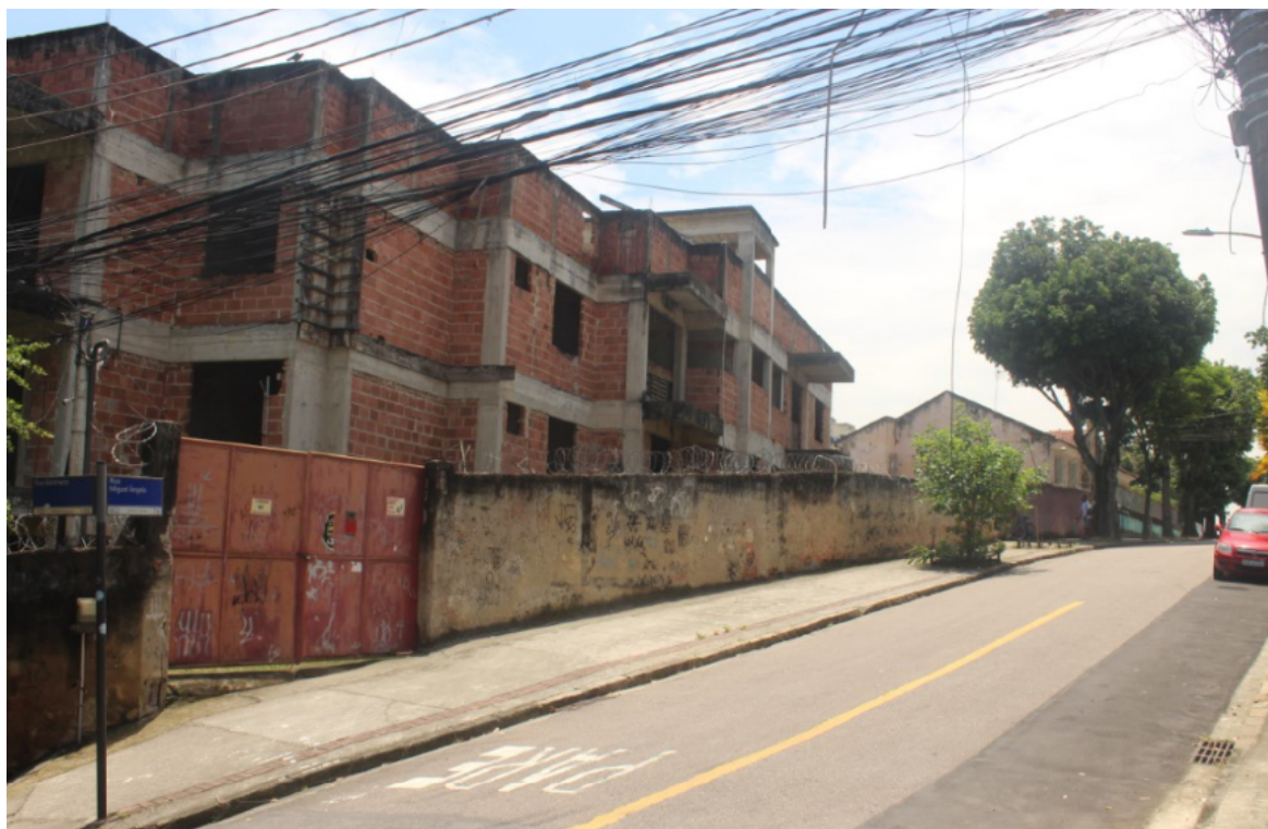
Foto 1: Recomposição de via na Rua Miguel Ângelo
