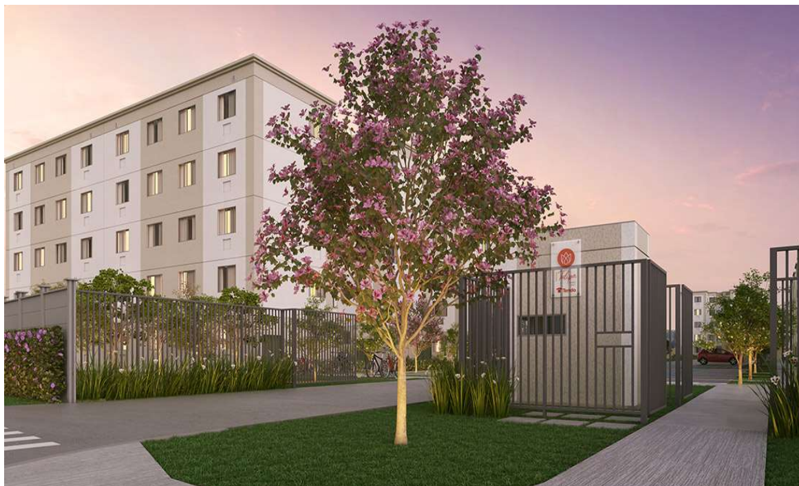
Foto 1 : futura fachada do condomínio
