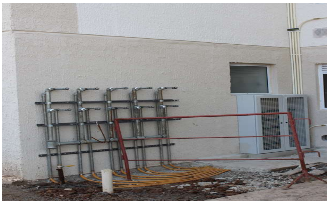
Foto 3 : local para instalação da caixa para regulador e medidores
