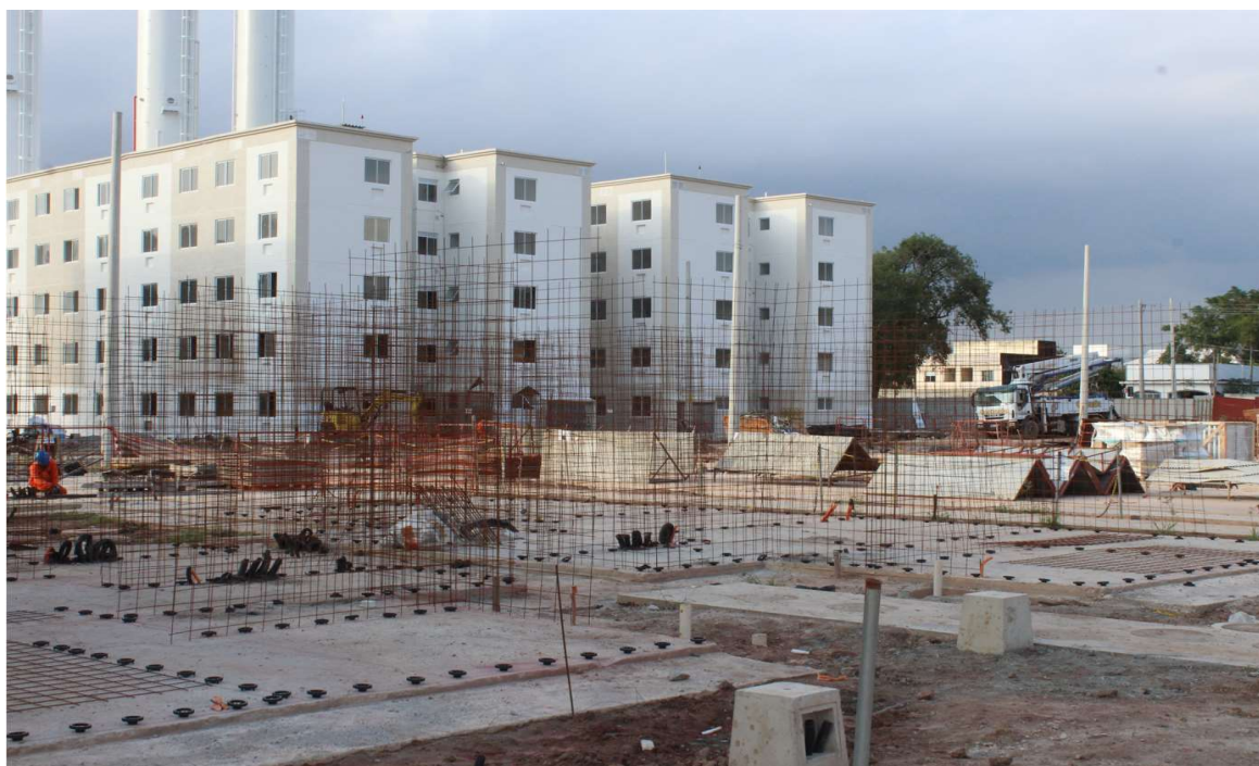
Foto 2 : situação atual da obra
