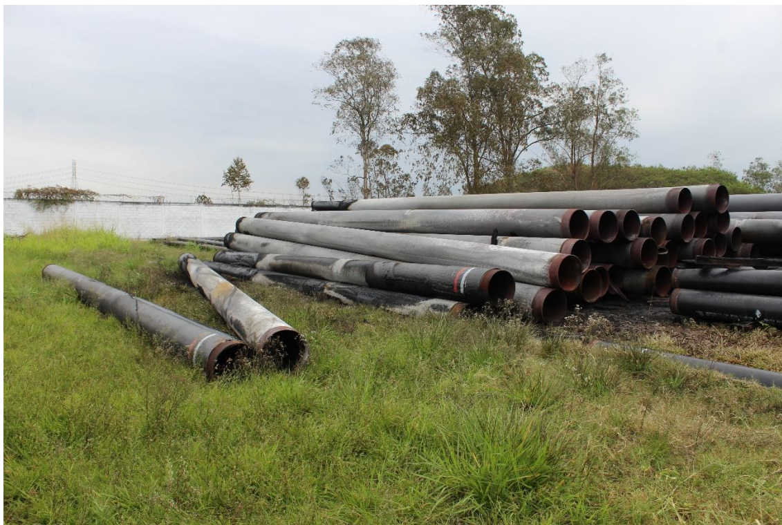
FOTO 7: Vista oposta da foto 5.
