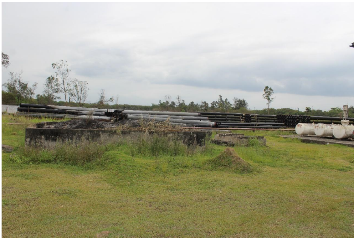
FOTO 3: Outro foco de incêndio, possivelmente originário de alguma chama advinda do incêndio ocorrido na vegetação externa da ERM.
