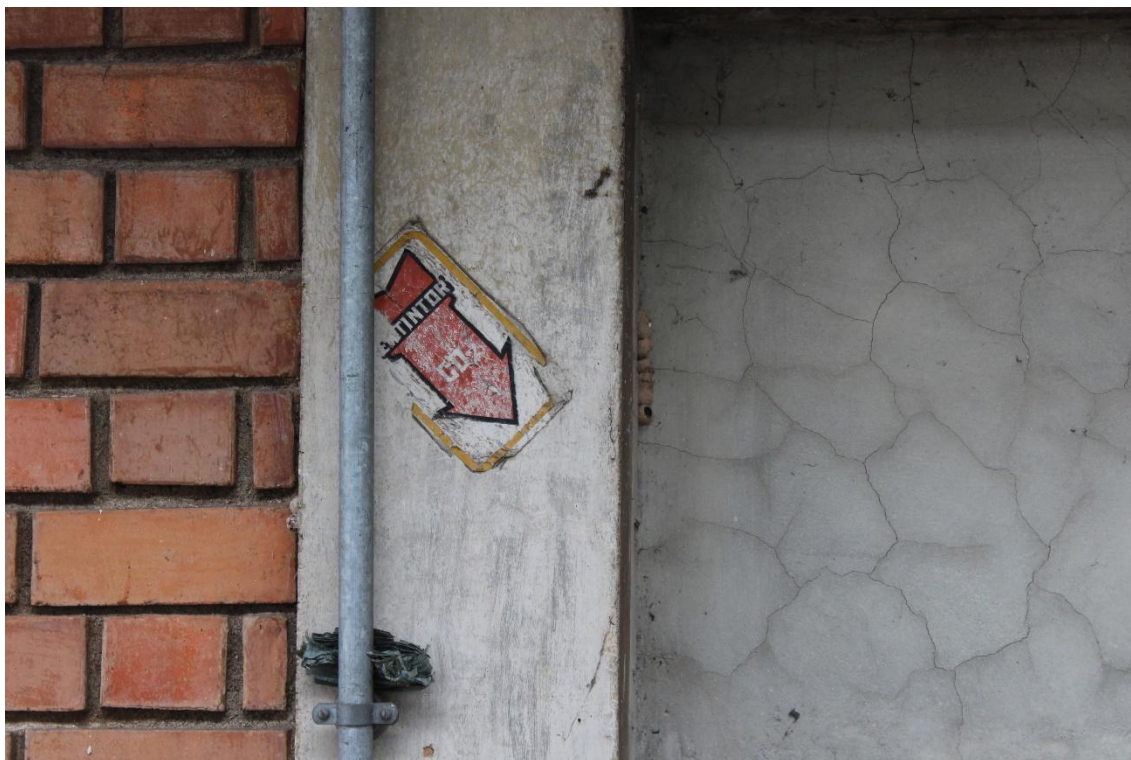
FOTO 27: Etiqueta de identificação de extintor de incêndio em mal estado de conservação.
