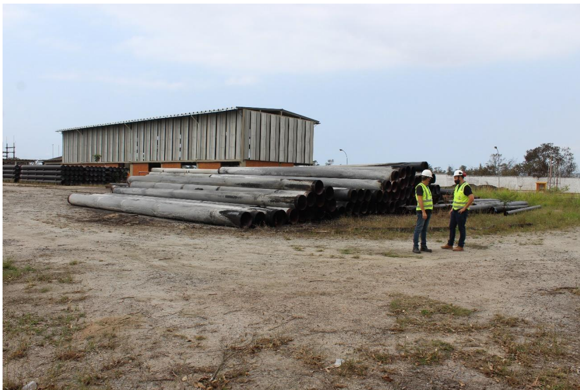
FOTO 5: Outro foco de incêndio, possivelmente originário de alguma chama advinda do incêndio ocorrido na vegetação externa da ERM.
