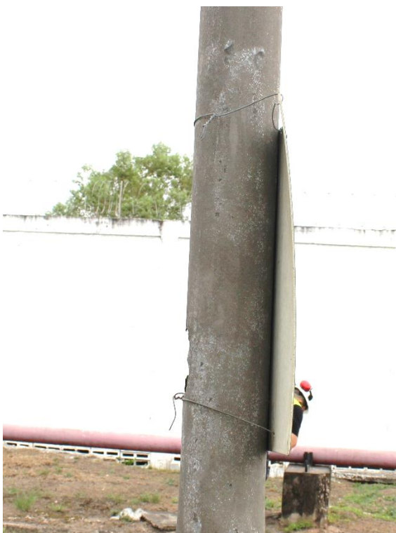
FOTO 20: Sinalização de rota de fuga fixada de forma indevida.
