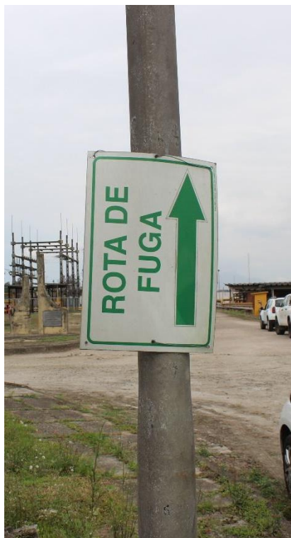
FOTO 20: Sinalização de rota de fuga fixada de forma indevida.
