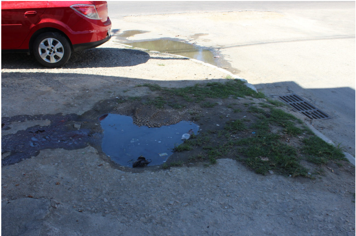
FOTO 15: Intervenção da CEDAE para reparo em tubulação de água avariada pela Concessionária CEG – foi solicitado que a CEG proceda com a recomposição da calçada.
