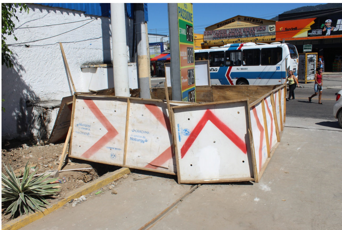
FOTO 2: Banheiro químico para os funcionários.
