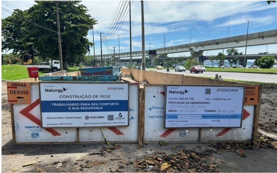
Foto 9: Placas de identificação da obra em uma abertura de vala próxima do início do trajeto.
