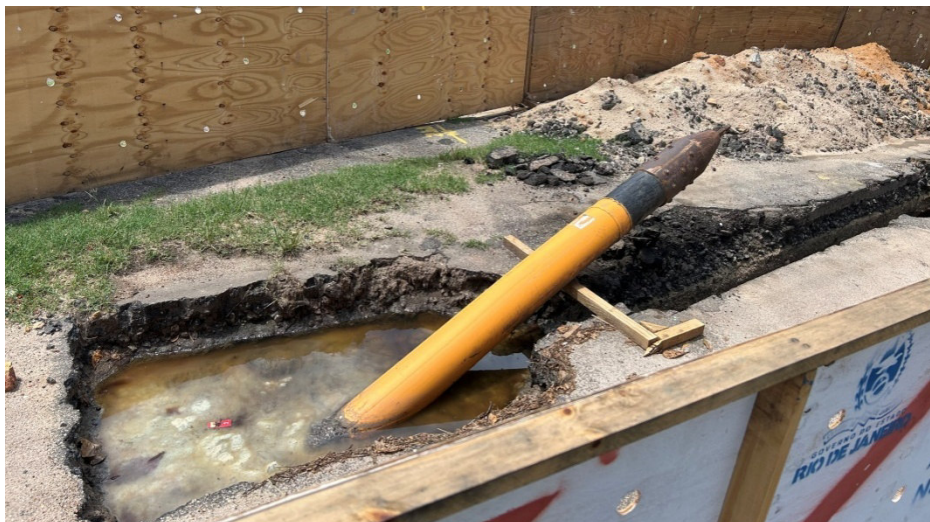
Foto 12: Ponto inicial da tubulação subsequente, instalada via perfuratriz.
