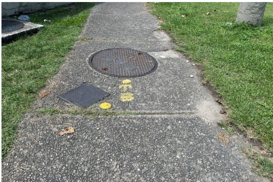
Foto 3: Ponto de término da rede de aço existente.
