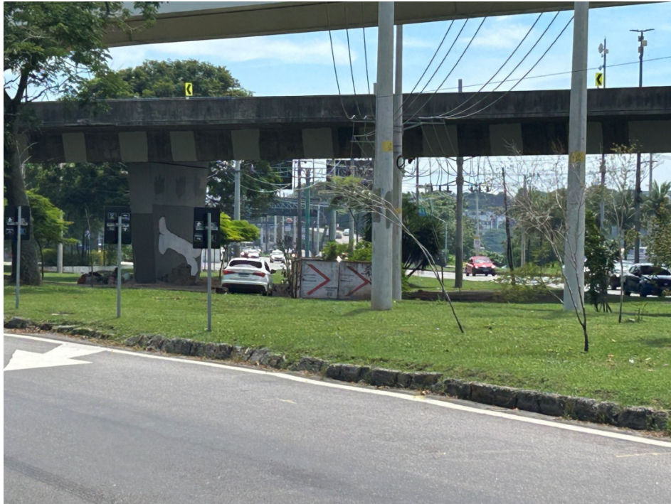
Foto 15: Via que será cruzada por abertura de vala e último ponto construído abaixo do viaduto.
