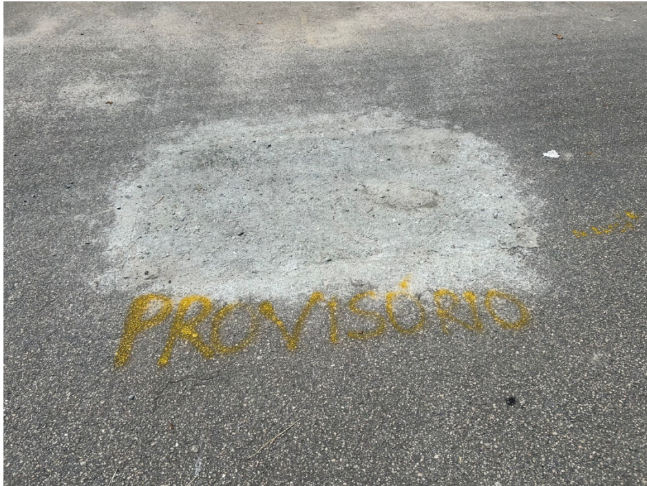
Foto 7: Trecho de recomposição provisória.
