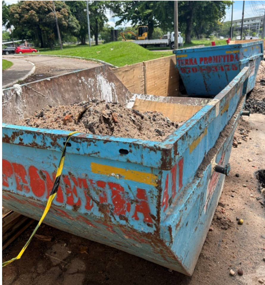
Foto 11: Armazenamento do material escavado para posterior utilização no fechamento da vala.
