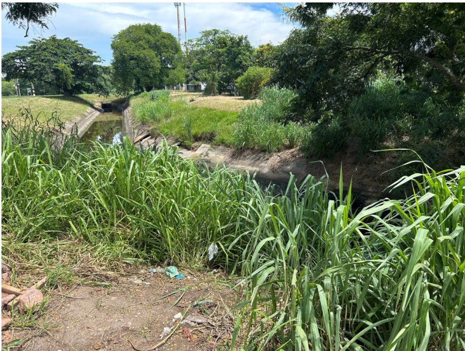
Foto 14: Curso d'água presente na área, que será contornado por meio de uma abertura de vala que cruzará a via.
