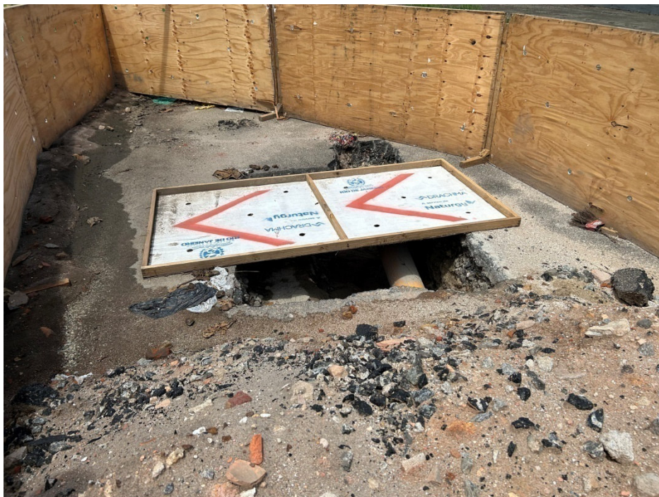
Foto 6: Ponto inicial da obra de reforço, que será ainda ligada à rede existente.
