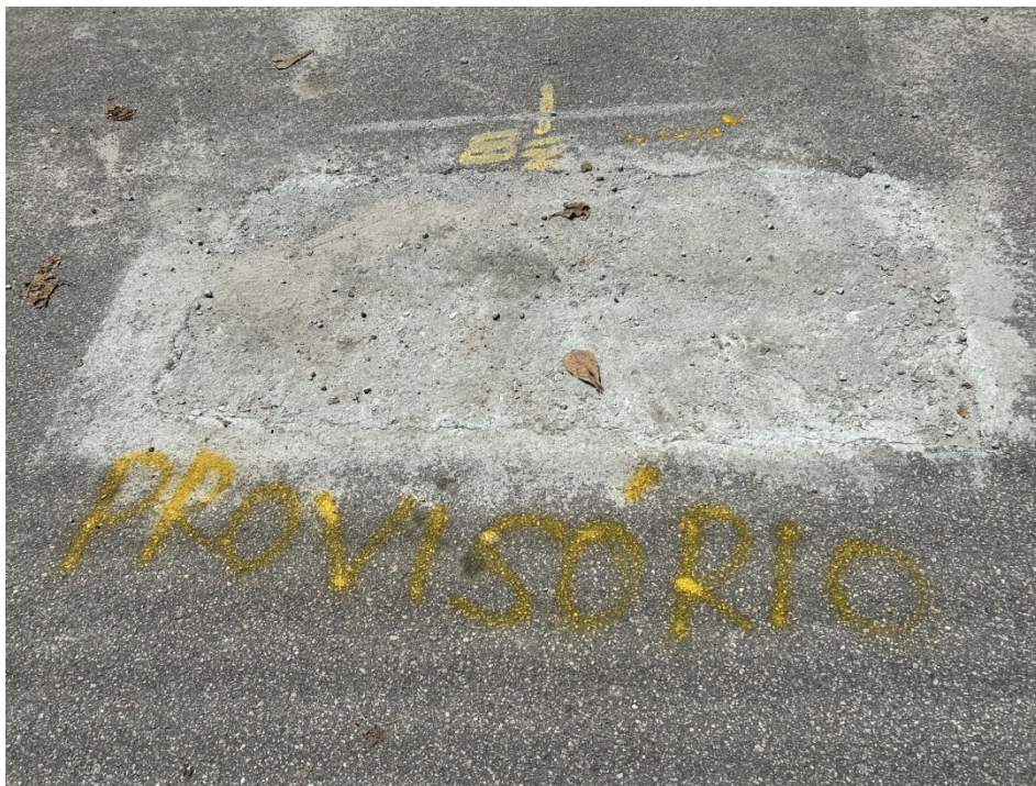
Foto 8: Trecho de recomposição provisória.
