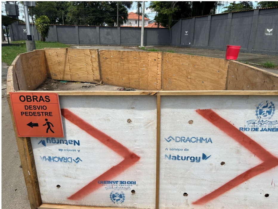
Foto 5: Início da obra de reforço, com tapumes de isolamento e sinalização.
