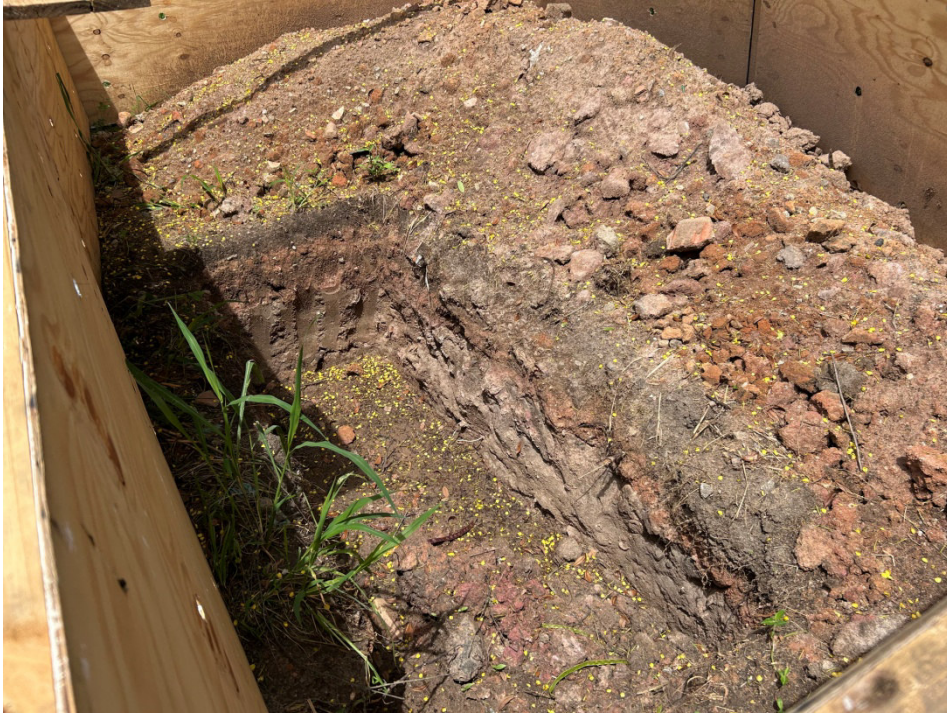
Foto 13: Ponto final da tubulação subsequente, não visível devido ao soterramento com terra.
