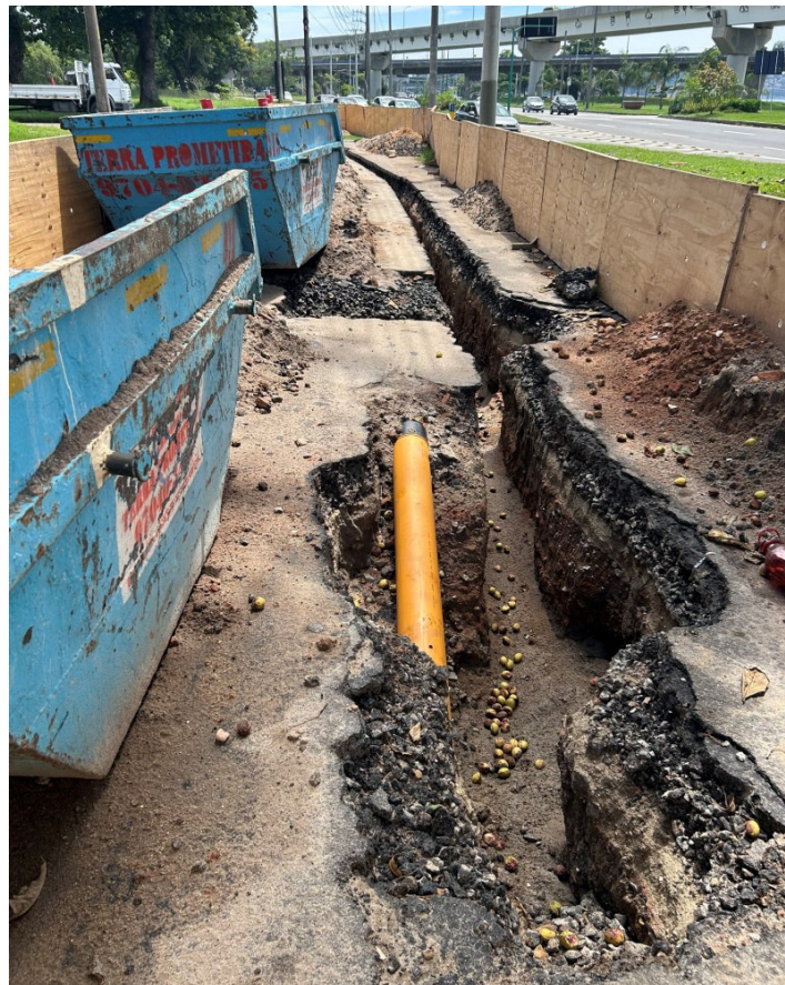
Foto 10: Abertura de vala próxima ao início do trajeto e ponta final da tubulação instalada por perfuratriz.
