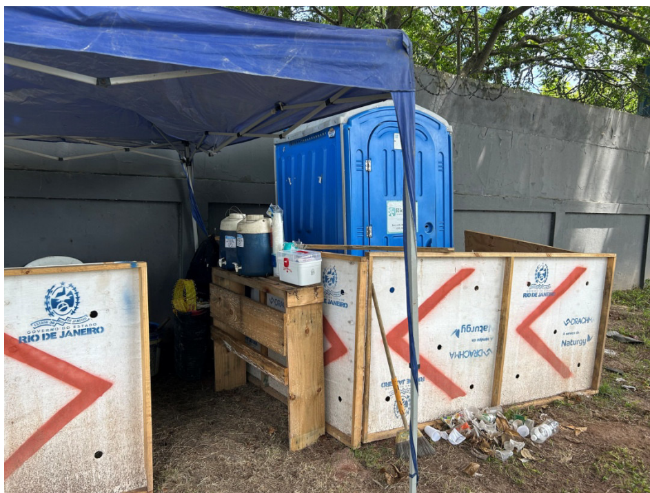
Foto 2: Área de vivência da obra.
