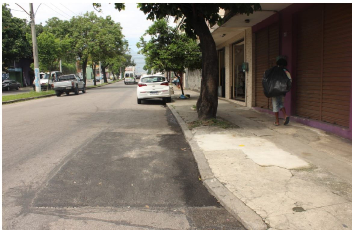
Foto 1: Recomposição de via e calçada
